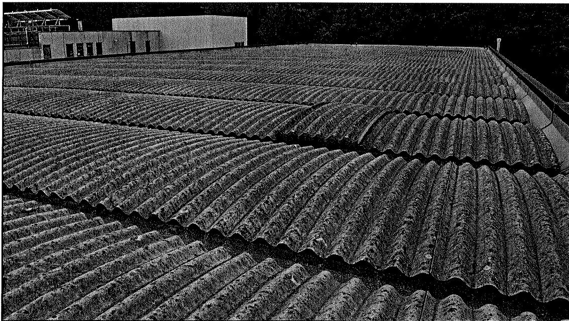
Figura 6. Copertura del fabbricato in "Eternit"
