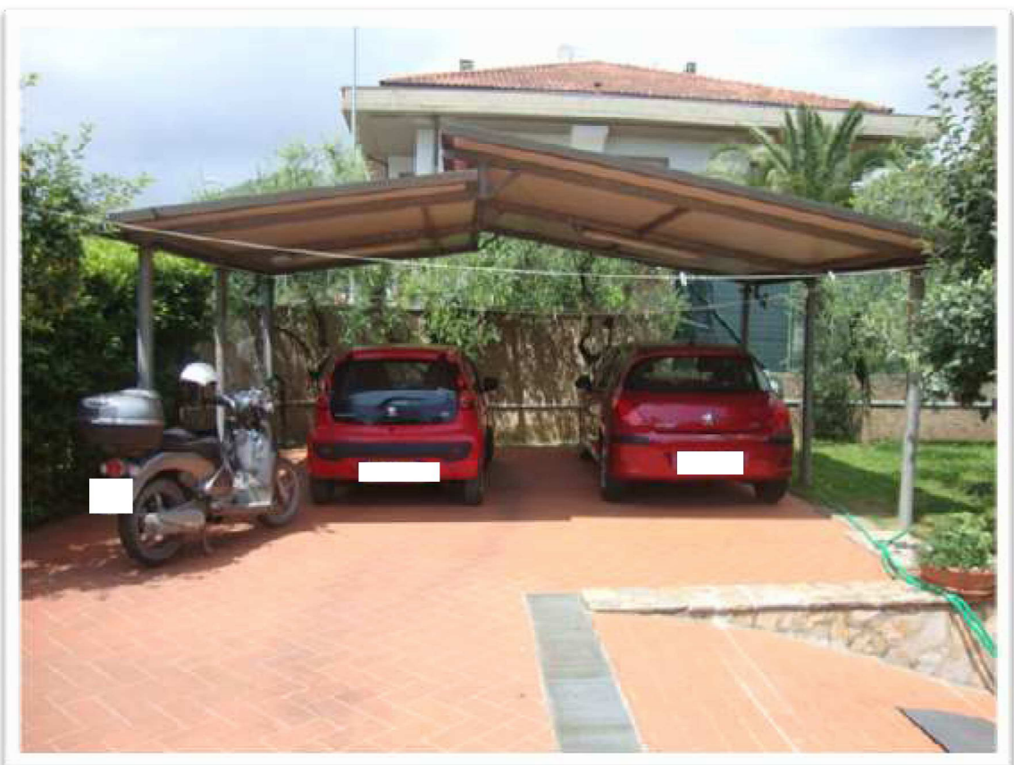
TETTOIA ADIBITA A POSTO AUTO
