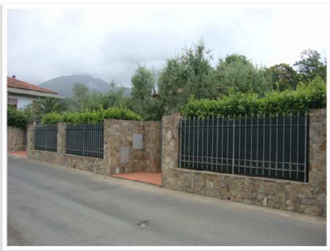
RECINZIONE LATO STRADA
