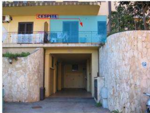
INGRESSO CONDOMINIALE DAL GARAGE SEMICANTINATO
