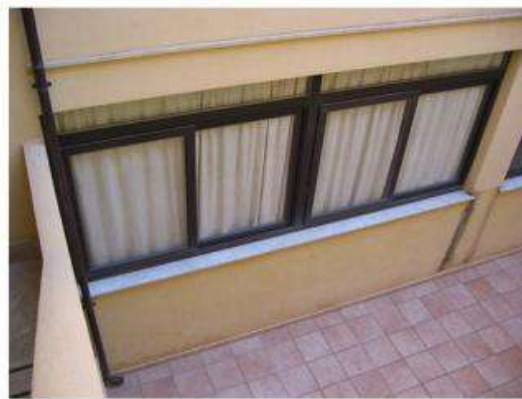
VETRATA CUCINA VERSO POZZO LUCE CONDOMINIALE
