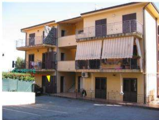
VEDUTA D'INSIEME PROSPETTO OVEST DAL PARCHEGGIO
