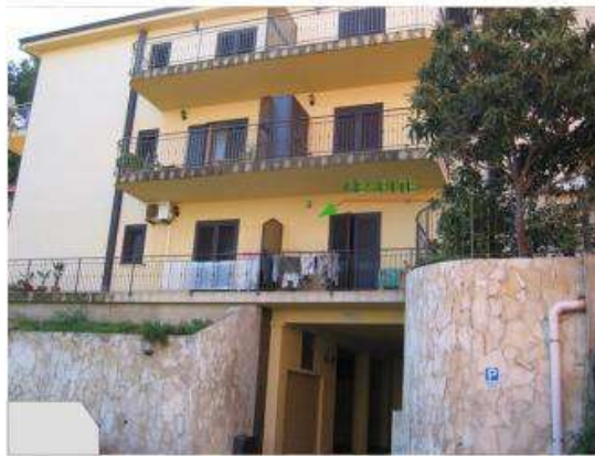
VEDUTA D'INSIEME PROSPETTO NORD DALLA VIA SABINA
