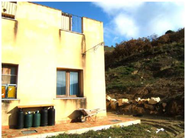
foto 21 Prospetto Posteriore (sud)
