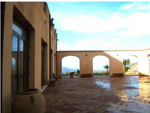
foto 9 Prospetto Principale (nord) Vista interna porticato
