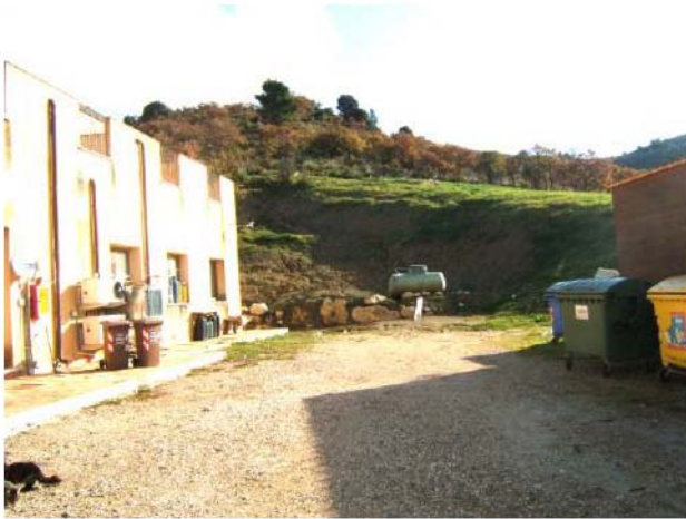
foto 19 Prospetto Posteriore (sud)
