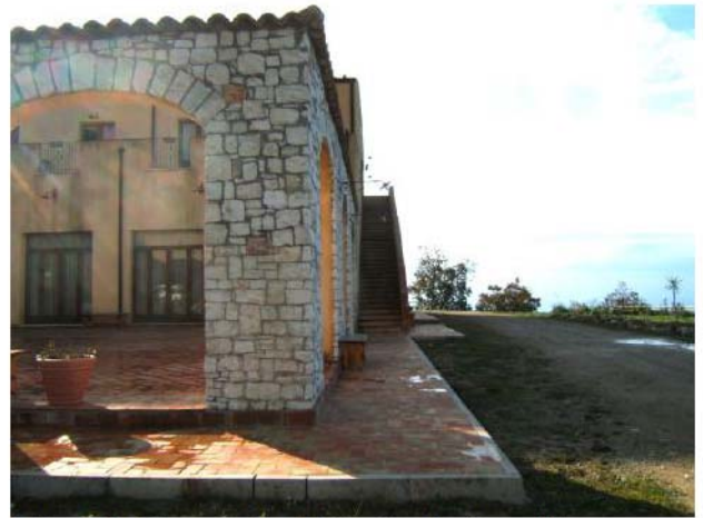
foto 14 Prospetto Principale (nord) Vista porticato
