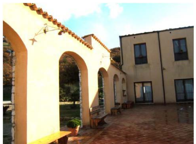
foto 12 Prospetto Principale (nord) Vista interna porticato
