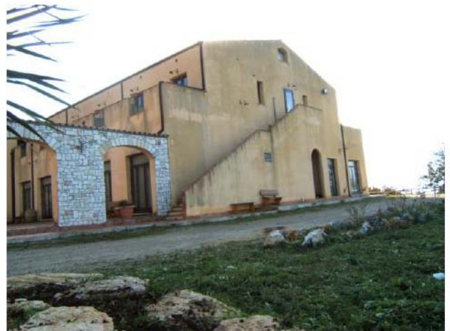
foto 16 Prospetto Laterale (ovest)
