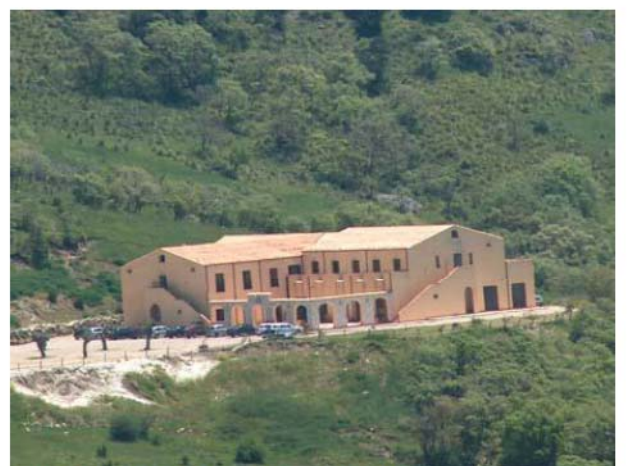
foto 30 Panoramica dell'albergo Vista nord-ovest
