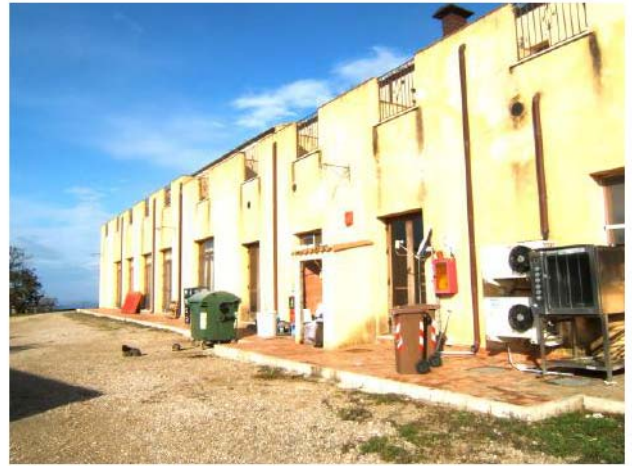
foto 20 Prospetto Posteriore (sud)
