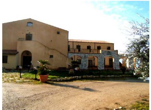
foto 4 Prospetto Principale (nord)
