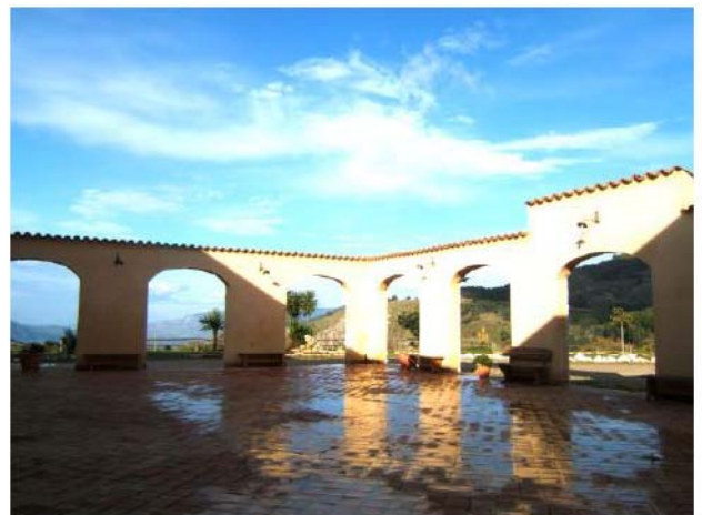
foto 10 Prospetto Principale (nord) Vista interna porticato
