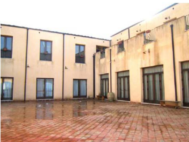
foto 11 Prospetto Principale (nord) Vista interna porticato ingresso sale trattenimenti
