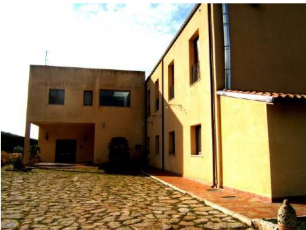
foto 5 Prospetto Principale (nord) Ingresso albergo
