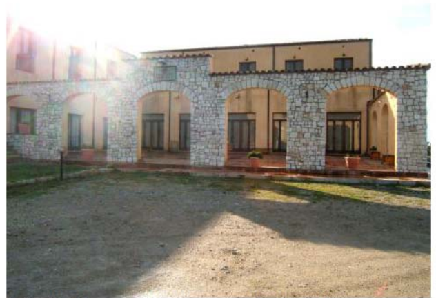
foto 8 Prospetto Principale (nord) Vista porticato
