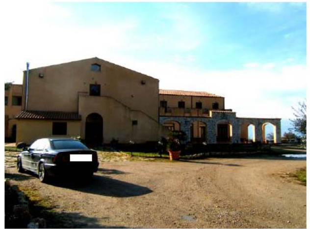
foto 2 Prospetto Principale (nord)
