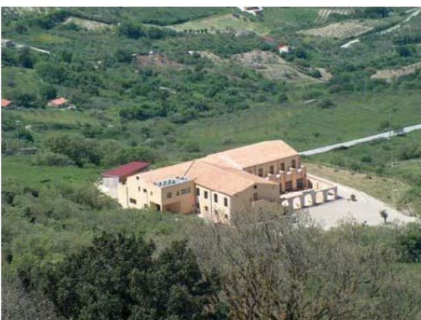
foto 29 Panoramica dell'albergo Vista nord-est
