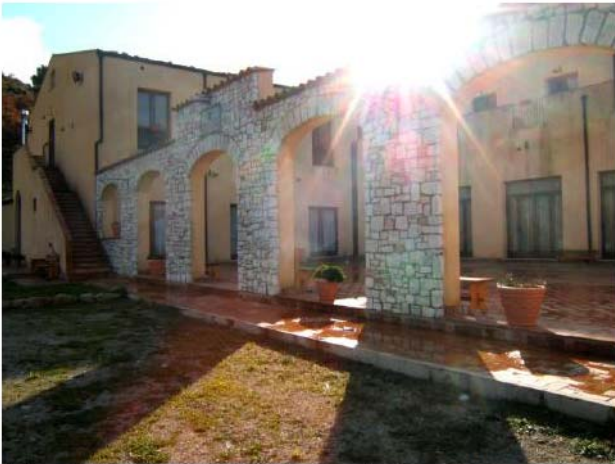
foto 7 Prospetto Principale (nord) Vista porticato
