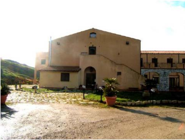
foto 1 Prospetto Principale (nord)
