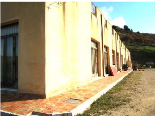
foto 17 Prospetto posteriore (sud) Vista Ingresso sala1 e alle cucine
