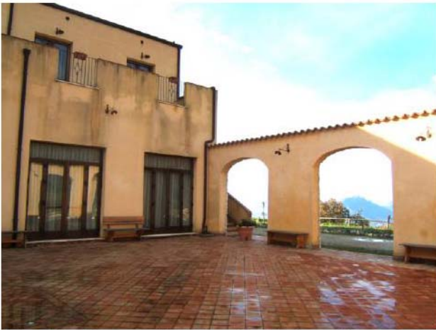
foto 13 Prospetto Principale (nord) Vista porticato
