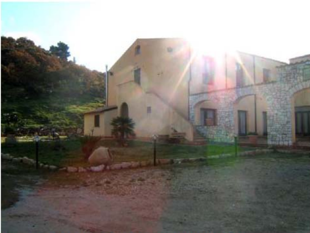
foto 3 Prospetto Principale (nord)
