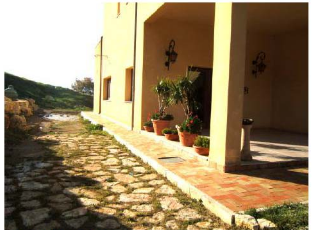
foto 22 Prospetto Laterale (est)
