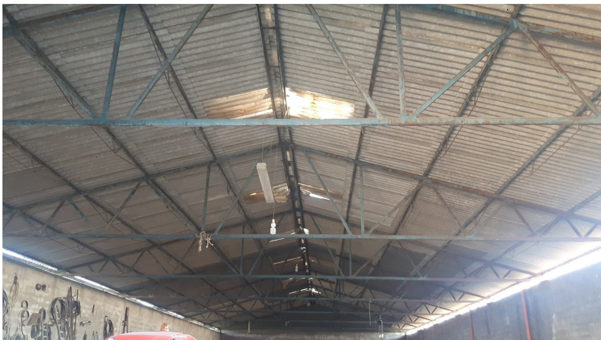
Foto n. 3. Particolare copertura in lastre di eternit del capannone industriale in Ribera, c/da Scirinda (part. n. 434, foglio di mappa n. 10).
