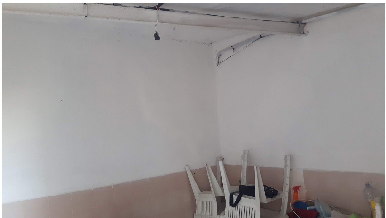
Foto n. 6. Interno locale ufficio adiacente al capannone industriale in Ribera, c/da Scirinda (part. n. 434, foglio di mappa n. 10).
