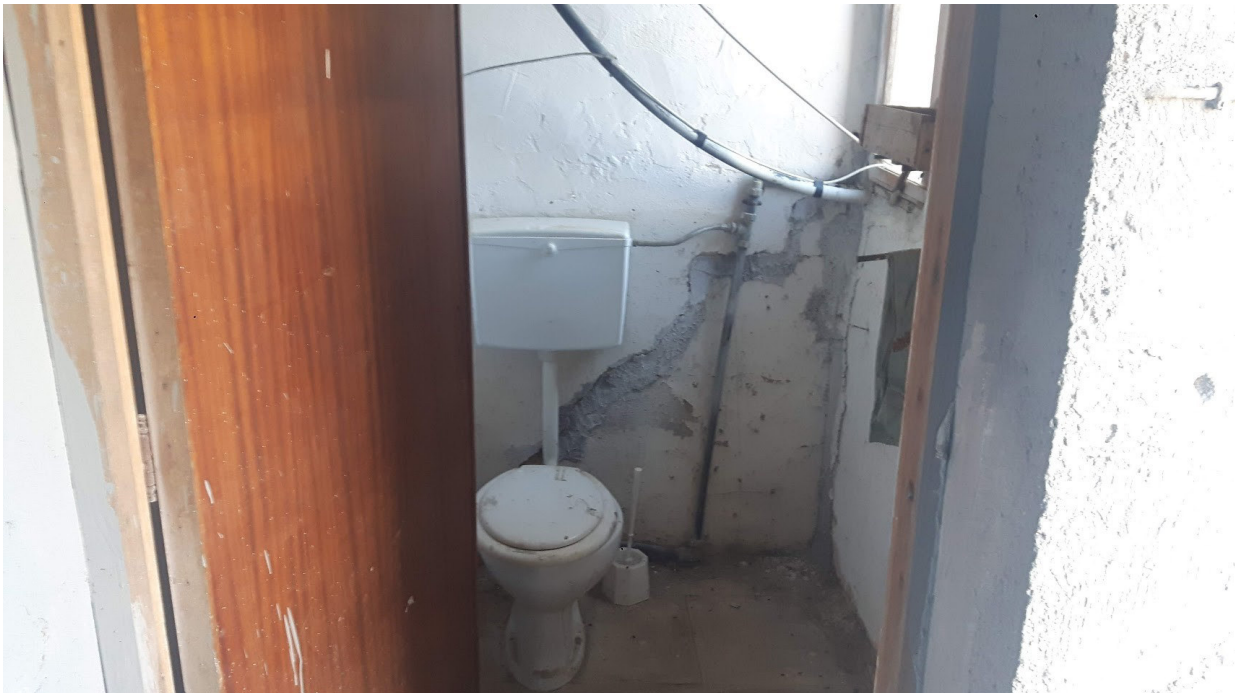
Foto n. 7. Interno w.c. adiacente al capannone industriale in Ribera, c/da Scirinda (part. n. 434, foglio di mappa n. 10).
