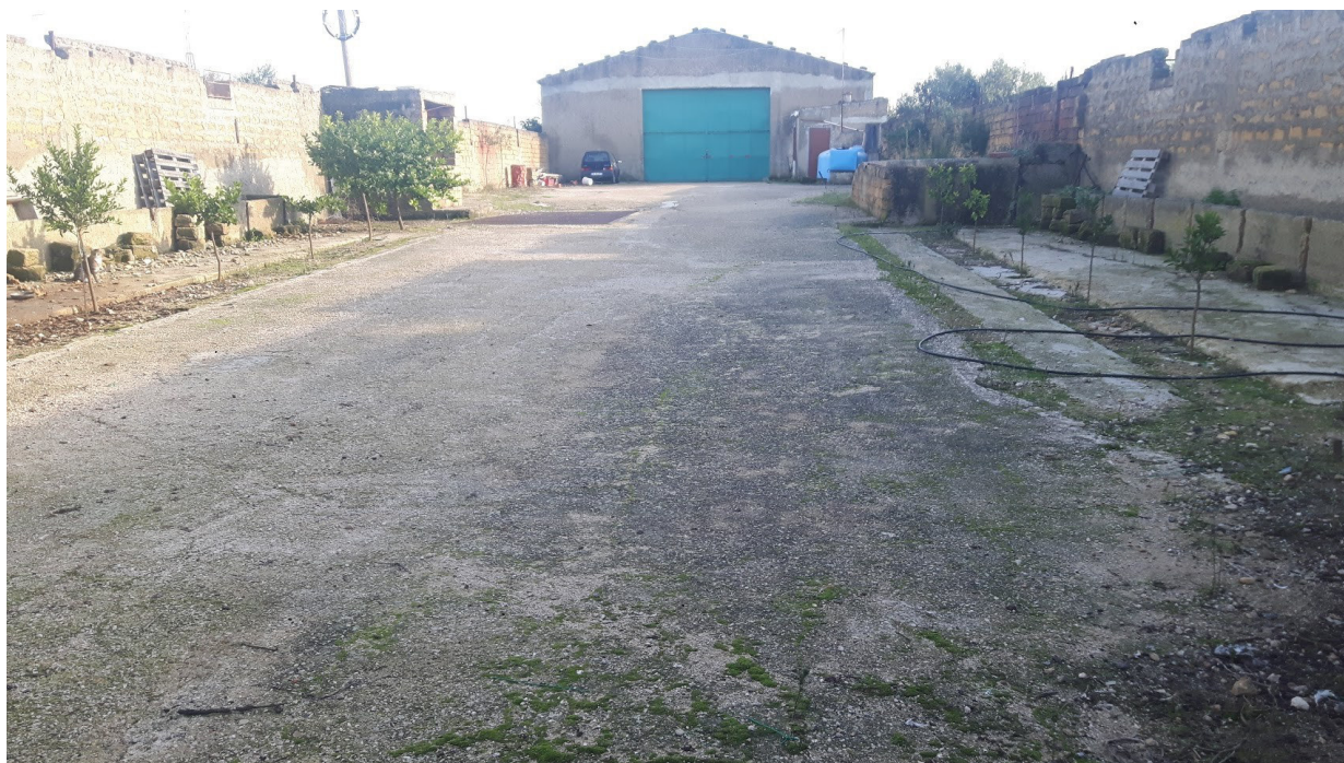
Foto n. 1. Capannone industriale in Ribera, c/da Scirinda (part. n. 434, foglio di mappa n. 10) con antistante piazzale.
