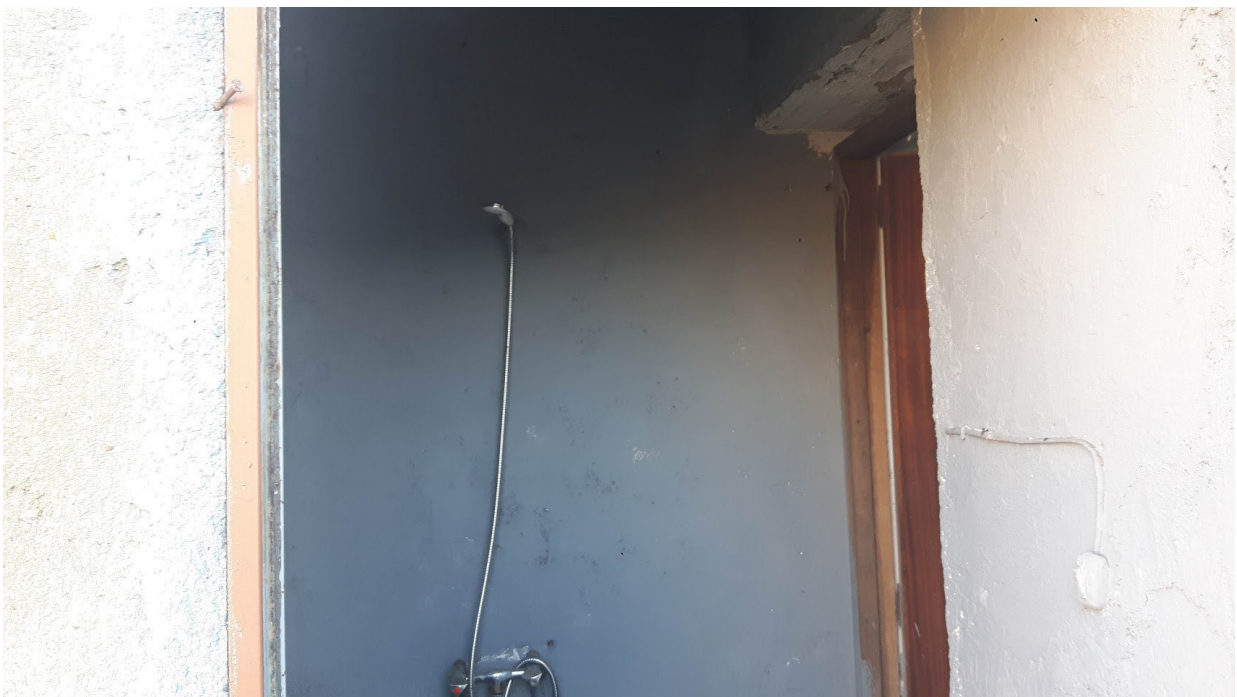
Foto n. 8. Interno w.c. adiacente al capannone industriale in Ribera, c/da Scirinda (part. n. 434, foglio di mappa n. 10).
