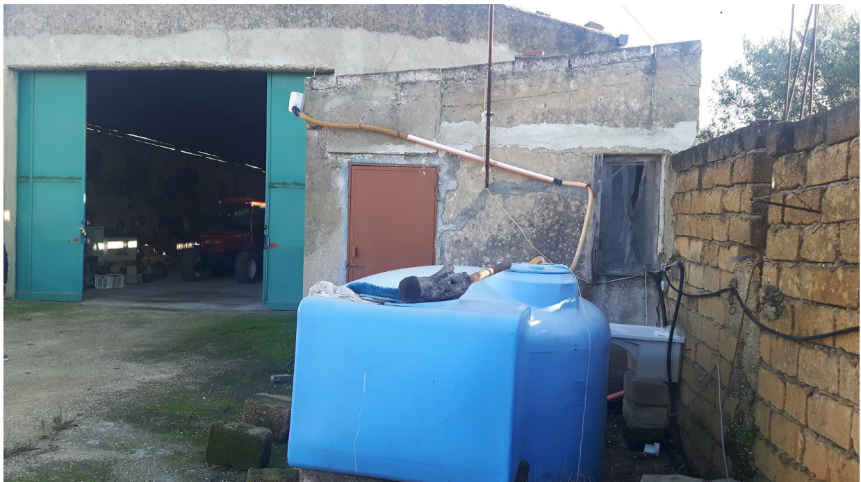
Foto n. 5. Esterni del w.c. e ingresso capannone industriale in Ribera, c/da Scirinda (part. n. 434, foglio di mappa n. 10).
