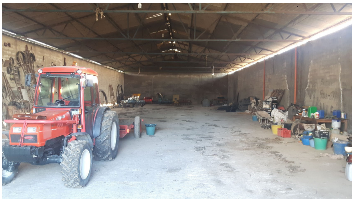
Foto n. 2. Interno del capannone industriale in Ribera, c/da Scirinda (part. n. 434, foglio di mappa n. 10).
