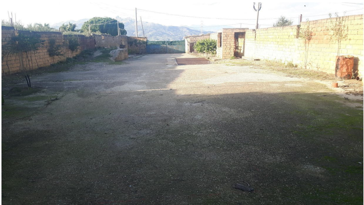
Foto n. 9. Piazzale antistante al capannone industriale in Ribera, c/da Scirinda (part. n. 434, foglio di mappa n. 10). Sullo sfondo, a destra, accanto al portone di ingresso, il locale pollaio.
