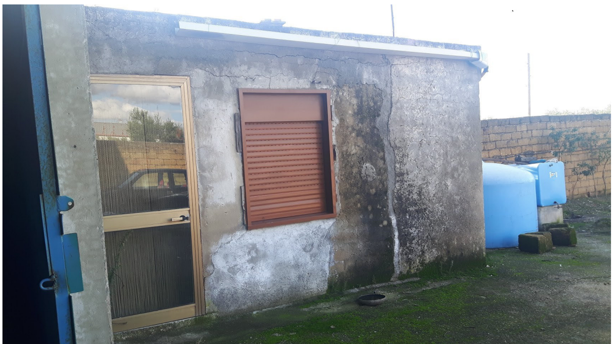
Foto n. 4. Esterni del locale ufficio adiacente al capannone industriale in Ribera, c/da Scirinda (part. n. 434, foglio di mappa n. 10).
