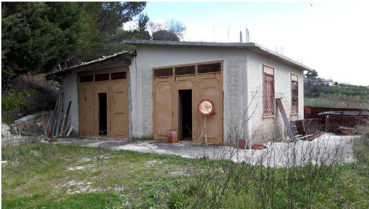
Foto n. 11. Magazzini in Sambuca di Sicilia, c/da Galluzzo (foglio 15, p.lle 248/1 e 248/2). Prospetto principale.
