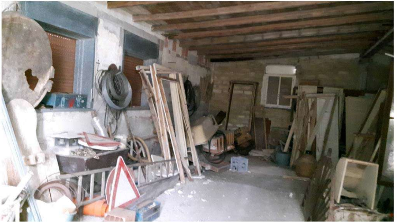
Foto n. 15. Magazzini in Sambuca di Sicilia, c/da Galluzzo (foglio 15, p.lle 248/1 e 248/2). Particolare interno magazzino grande (p.lla 248/2).
