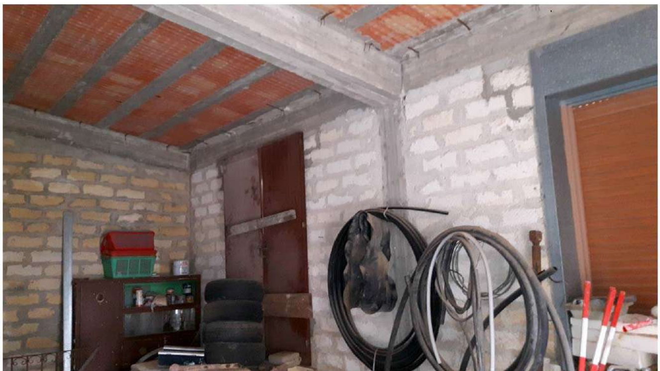
Foto n. 14. Magazzini in Sambuca di Sicilia, c/da Galluzzo (foglio 15, p.lle 248/1 e 248/2). Particolare interno magazzino piccolo (p.la 248/1).
