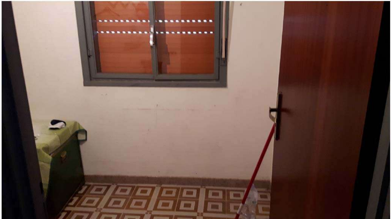
Foto n. 23. Fabbricato urbano in Sambuca di Sicilia, c/da Adragna (foglio 14, p.la 260). Particolare interno secondo corpo di fabbrica.
