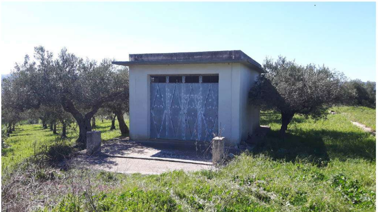
Foto n. 8. Magazzino con superficie coperta di mq. 40,00 circa (foglio 27, p.la 356/2) in Sambuca di Sicilia, c/da Sgarretta. Prospetto principale.
