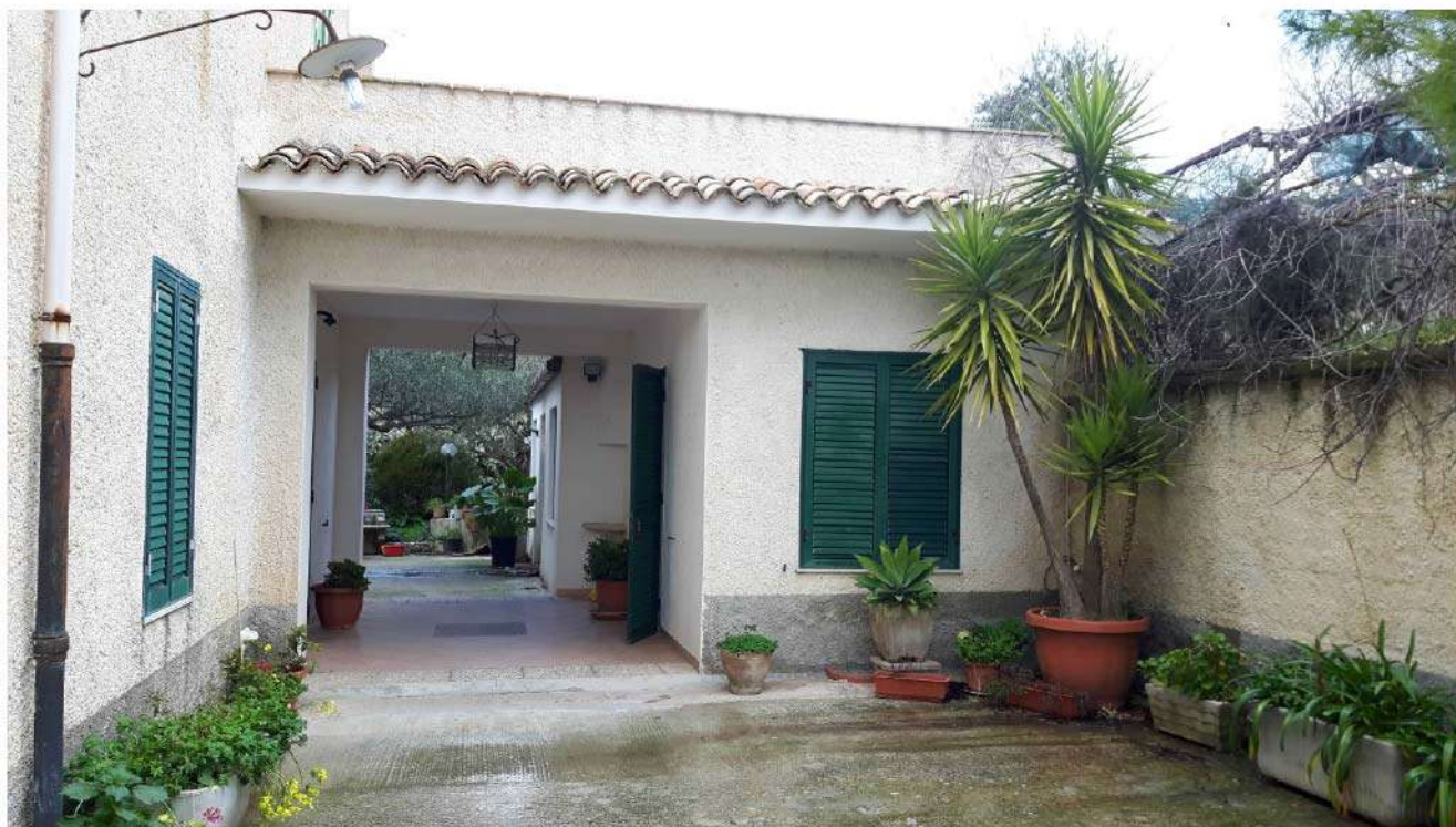
Foto n. 18. Fabbricato urbano in Sambuca di Sicilia, c/da Adragna (foglio 14, p.lla 260). Prospetto principale su via Mulino-Adragna-Cicala
