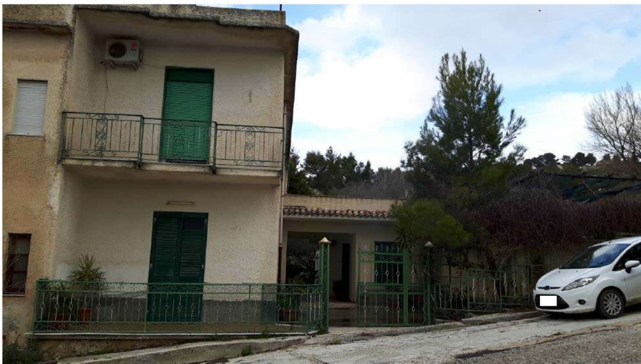
Foto n. 17. Fabbricato urbano in Sambuca di Sicilia, c/da Adragna (foglio 14, p.lla 260). Prospetto principale su via Mulino-Adragna-Cicala
