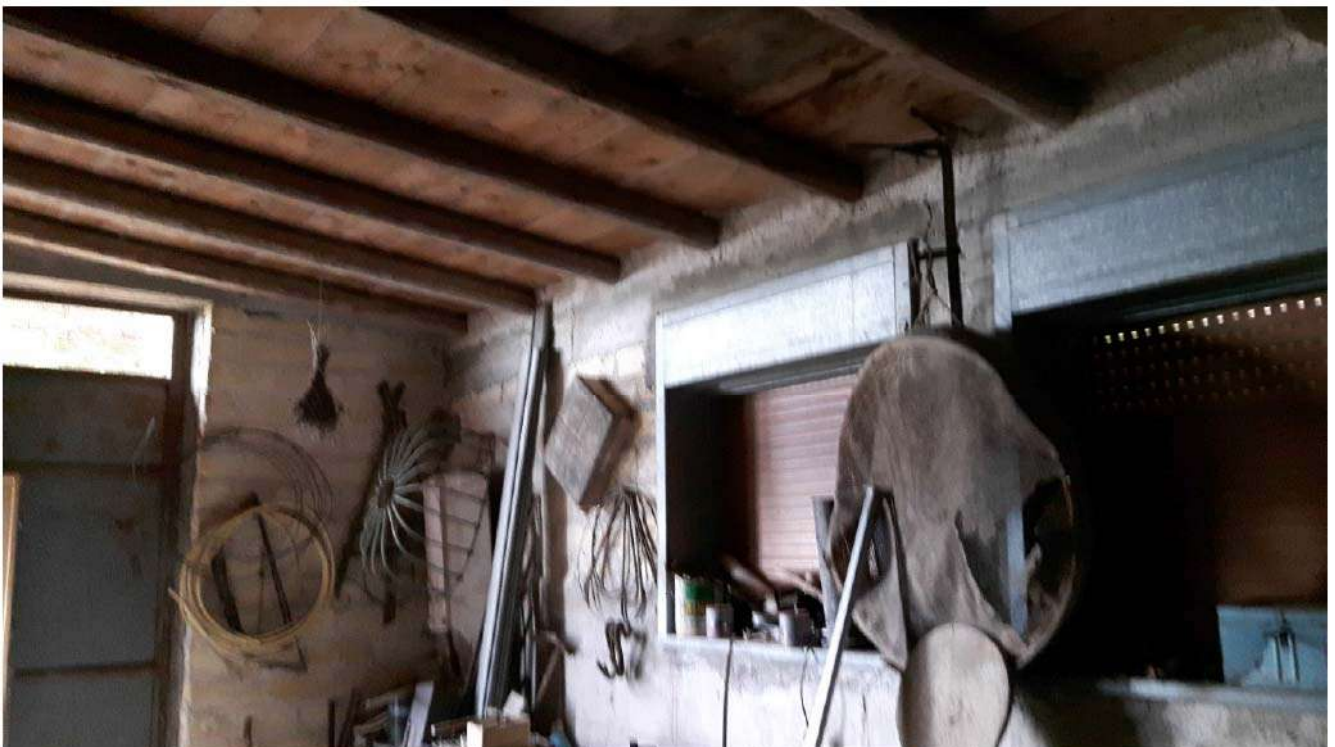
Foto n. 16. Magazzini in Sambuca di Sicilia, c/da Galluzzo (foglio 15, p.lle 248/1 e 248/2). Particolare interno magazzino grande (p.lla 248/2).
