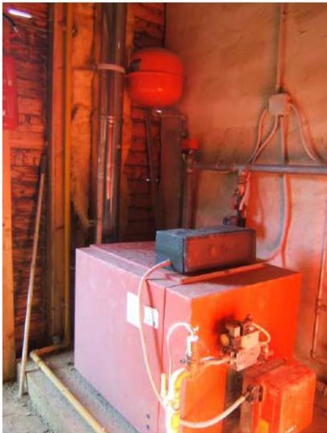
foto 7 Impianto Riscaldamento e acqua sanitaria
