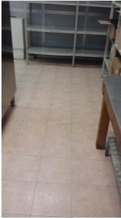
N.7: pavimentazione cantinato.
