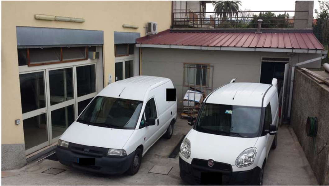
N.3: vista prospetto principale cantinato ed ampliamento.
