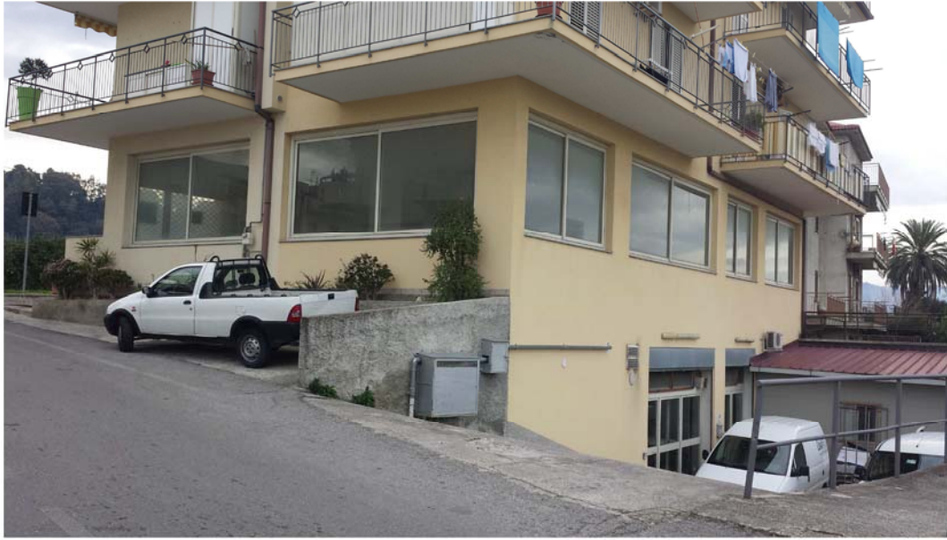
N.1: vista accesso carrabile, da nuova viabilità, all'unità immobiliare.
