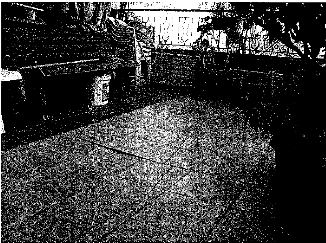
FOTO 7: Abbassamento della pavimentazione con conseguenti lesioni e rotture delle piastrelle
