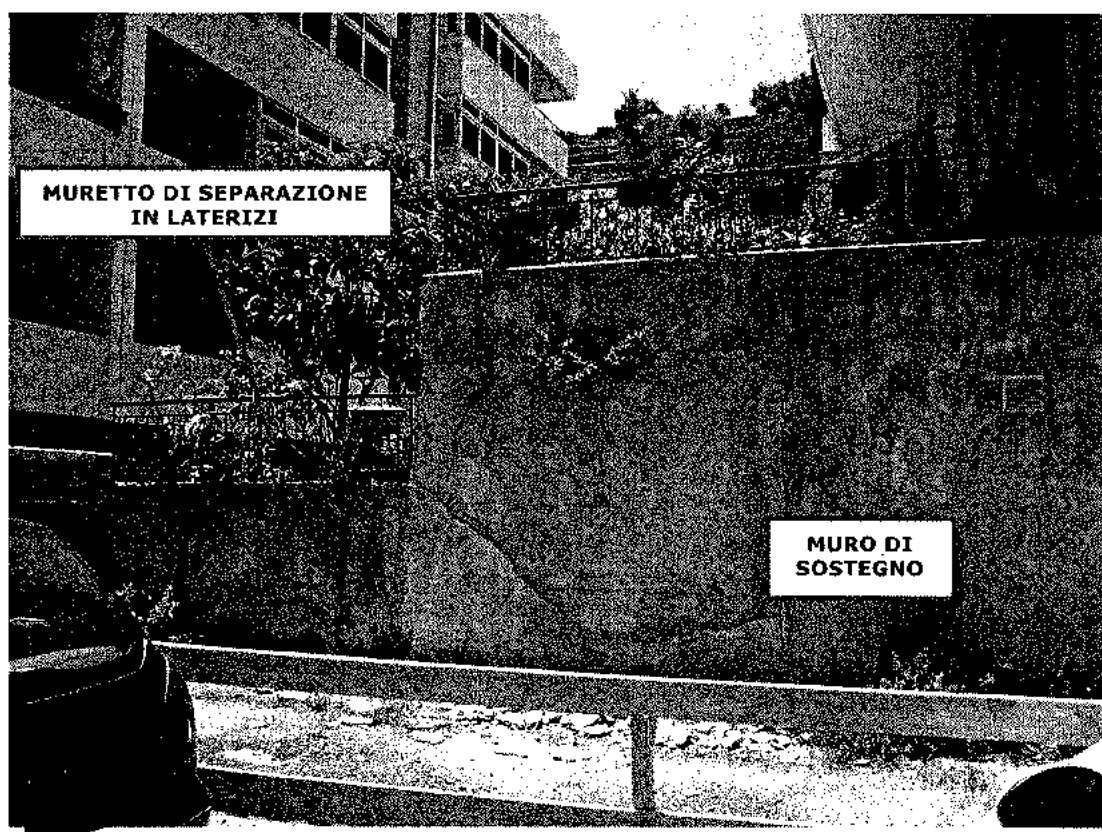
FOTO 4: Muro di sostegno al confine con il parcheggio condominiale e limitrofo muretto di separazione in laterizi
