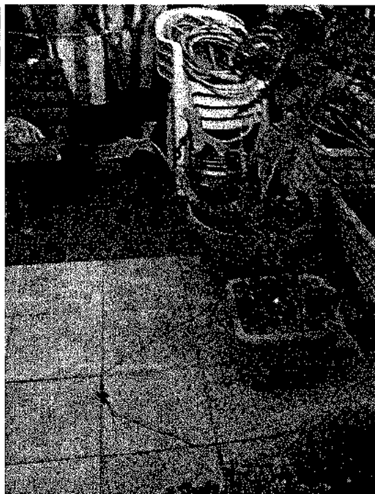
FOTO 8 e 9: Abbassamento della pavimentazione con conseguenti lesioni e rotture delle piastrelle
