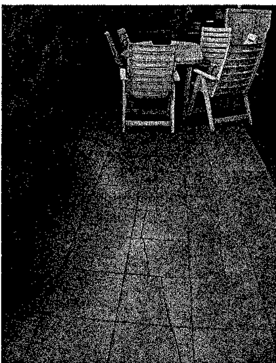
FOTO 8 e 9: Abbassamento della pavimentazione con conseguenti lesioni e rotture delle piastrelle
