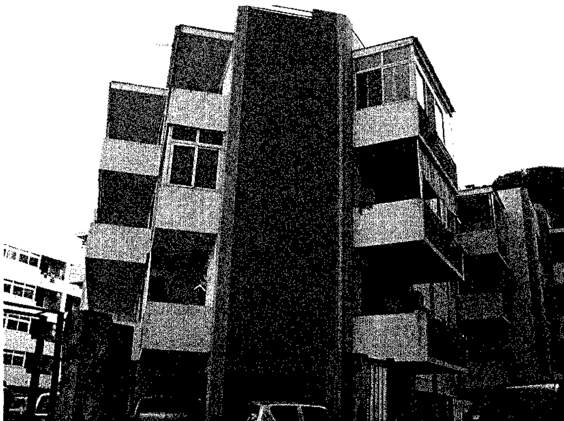
FOTO 1: Prospetto nord-est del fabbricato cui l'immobile appartiene
