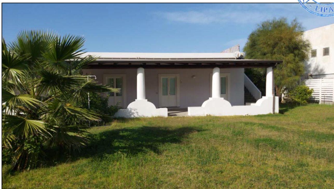
FOTO N.6 – Corpo B part. 882 sub. 9
