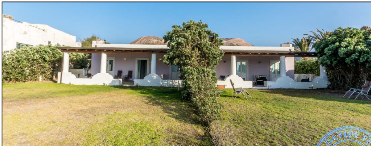
FOTO N.1 – Corpo B part. 882 sub. 10-11
