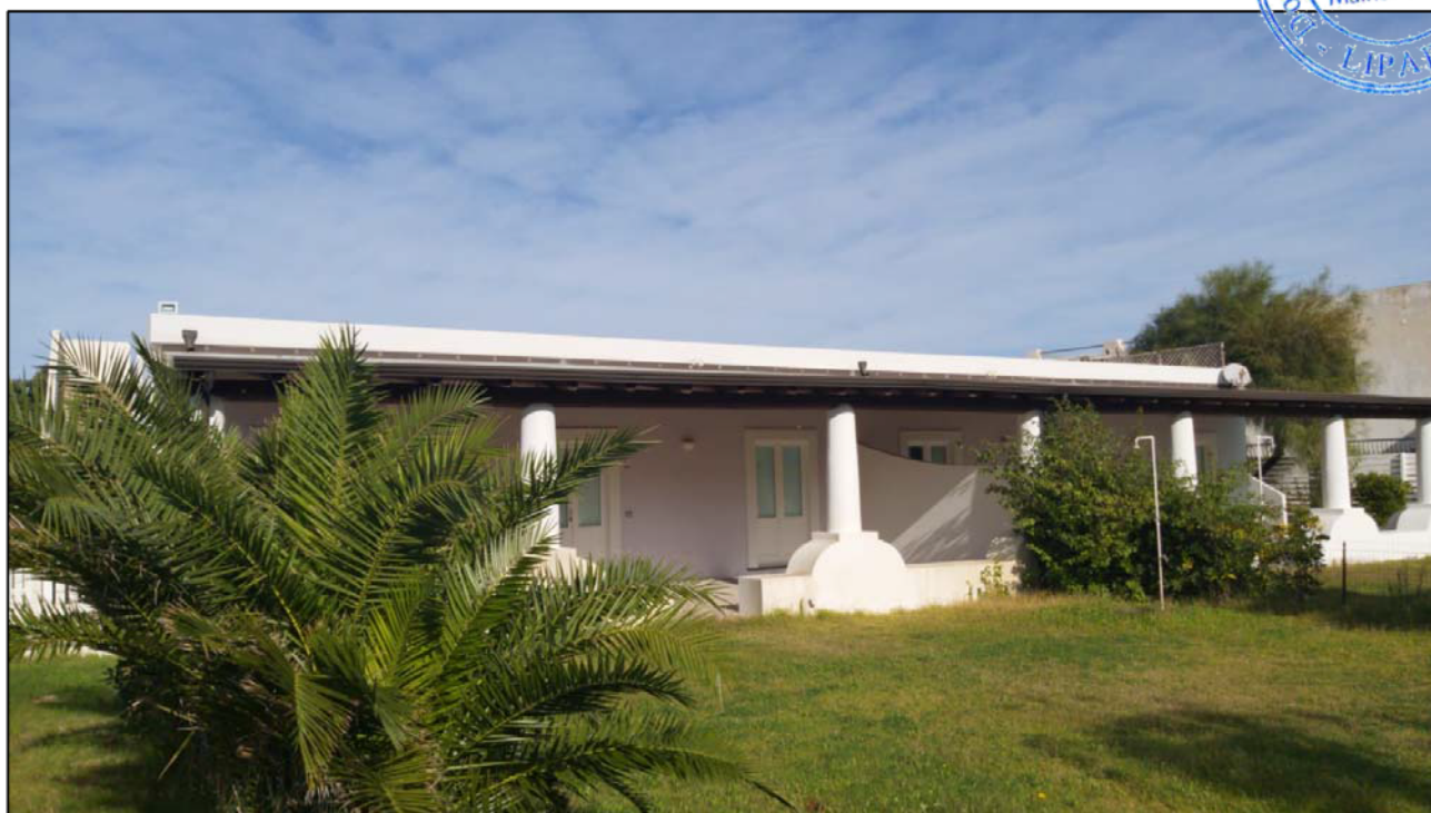
FOTO N.4 – Corpo B part. 882 sub. 8-9
