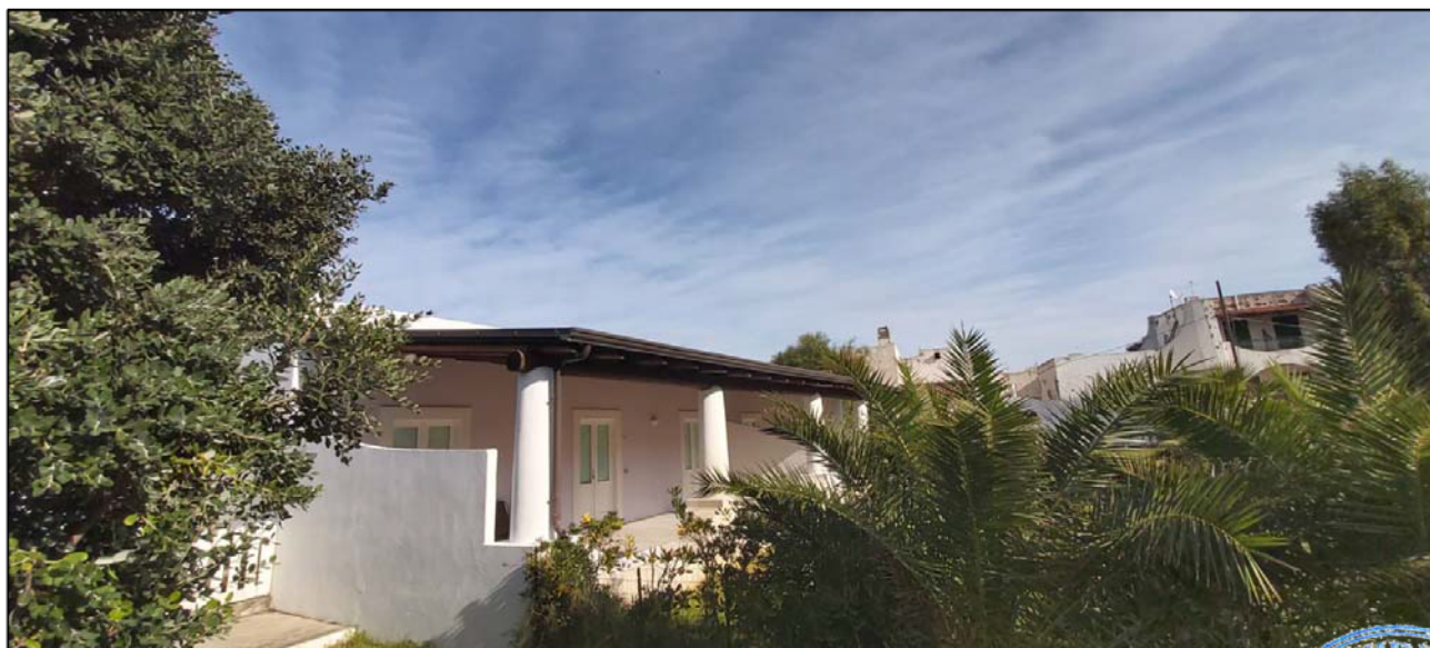
FOTO N.5 – Corpo B part. 882 sub. 8
