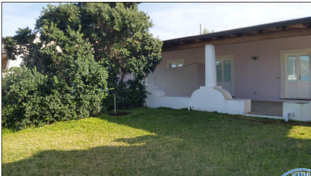
FOTO N.3 – Corpo B part. 882 sub. 11
