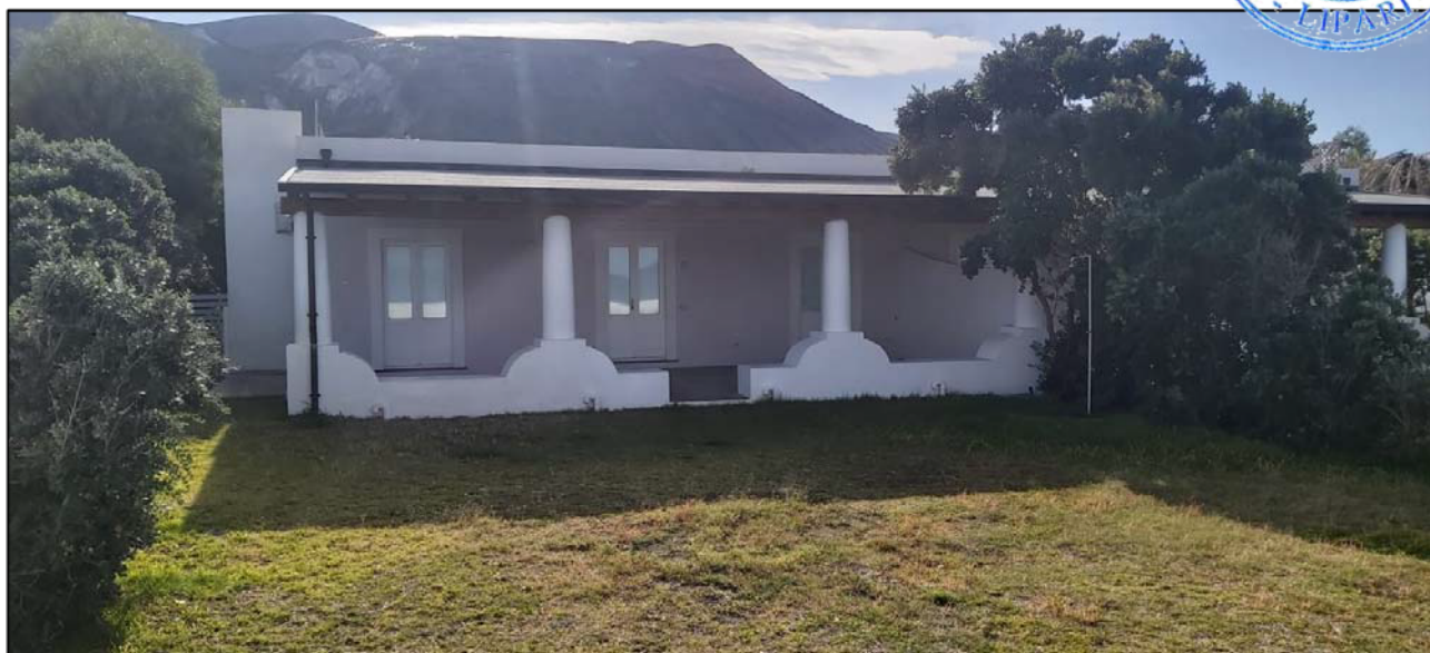
FOTO N.2 – Corpo B part. 882 sub. 10
