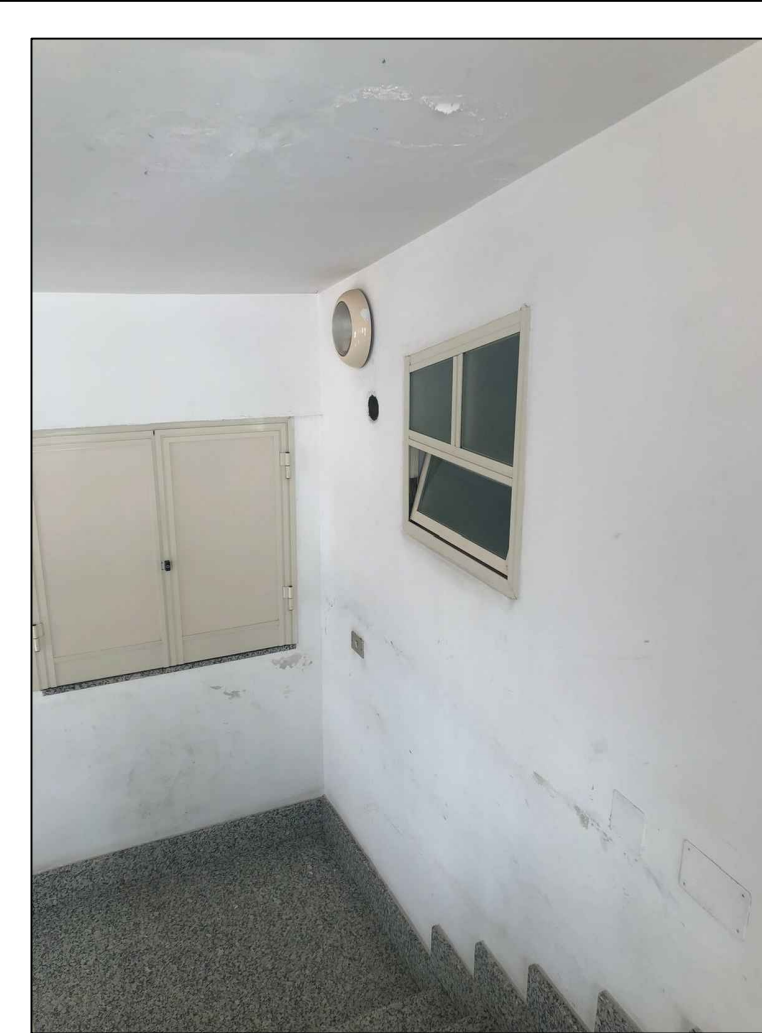
Foto 8 - Vano scala condominiale
