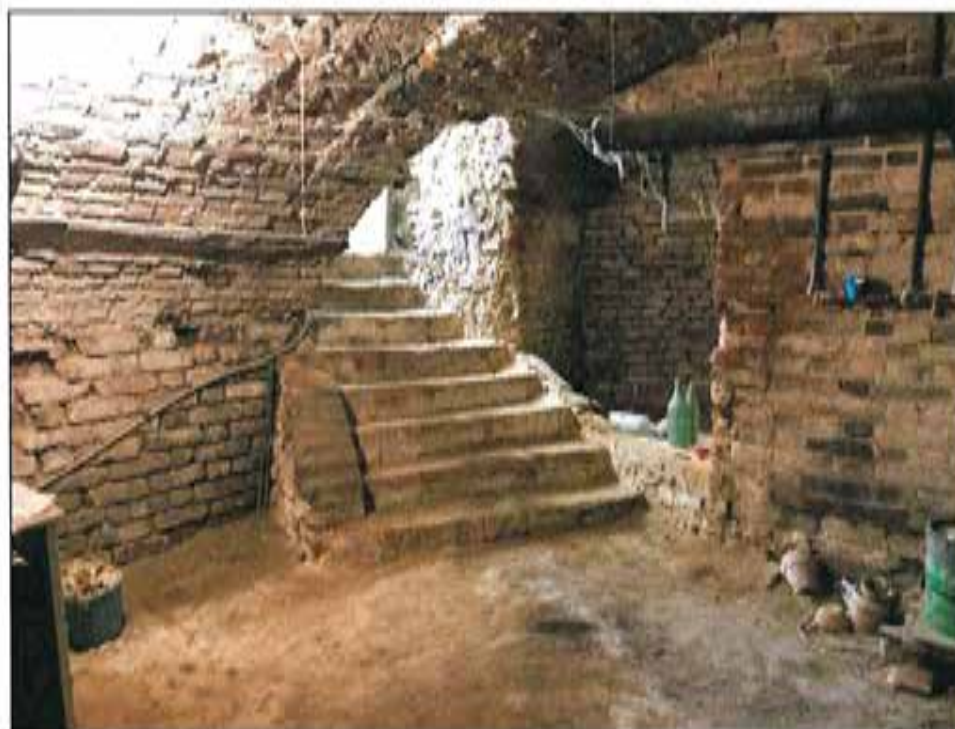
Immagine 49: cantina a piano interrato
