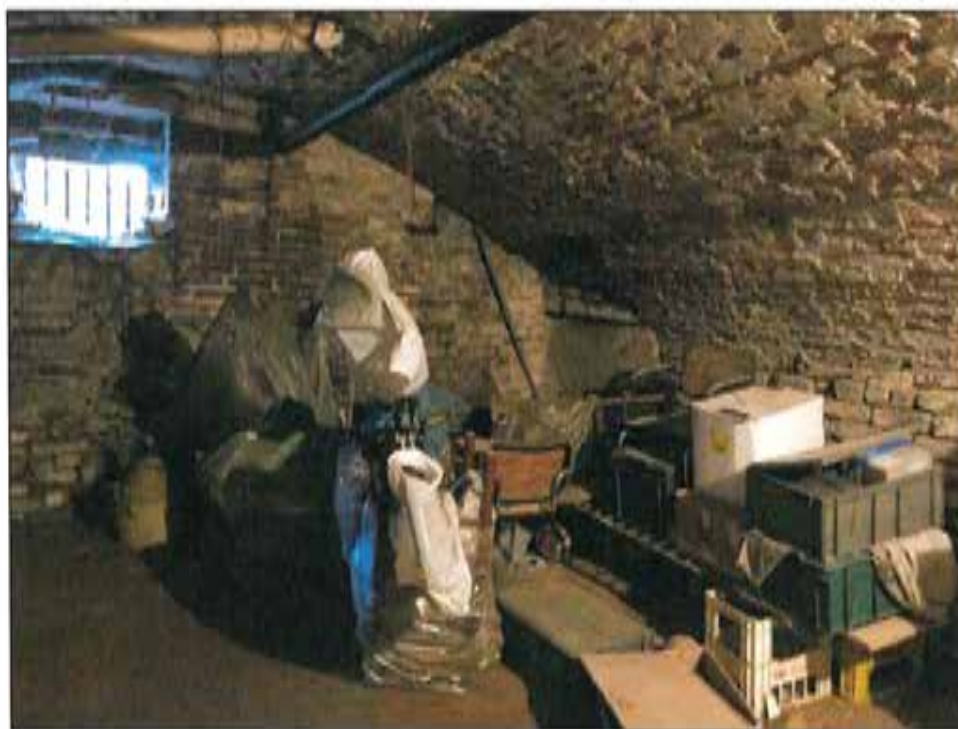
Immagine 47: cantina a piano interrato
