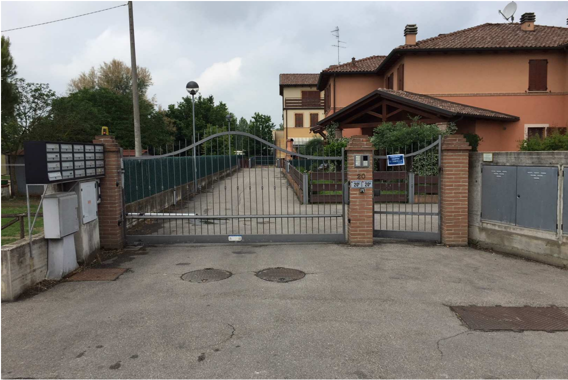
cancelli di accesso al complesso immobiliare su via Pero
