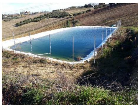
Vasca dell'acqua piovana con recinzione incompleta
