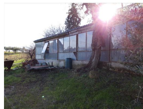
Attrezzaia - vista del portico fronte nord
