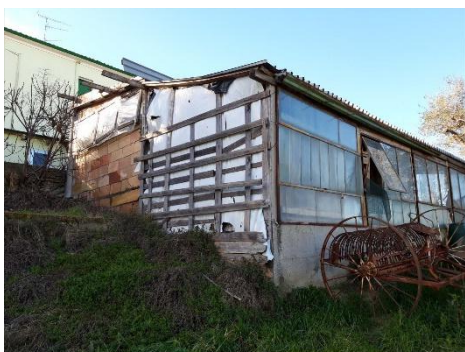
Attrezzaia - vista nord est
