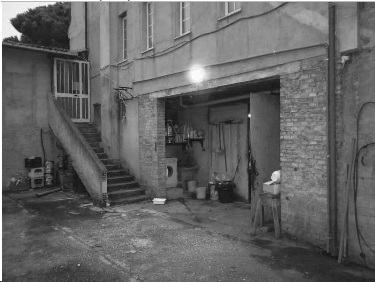
FOTOGRAFIA N.6: Vista ingresso a piano interrato
