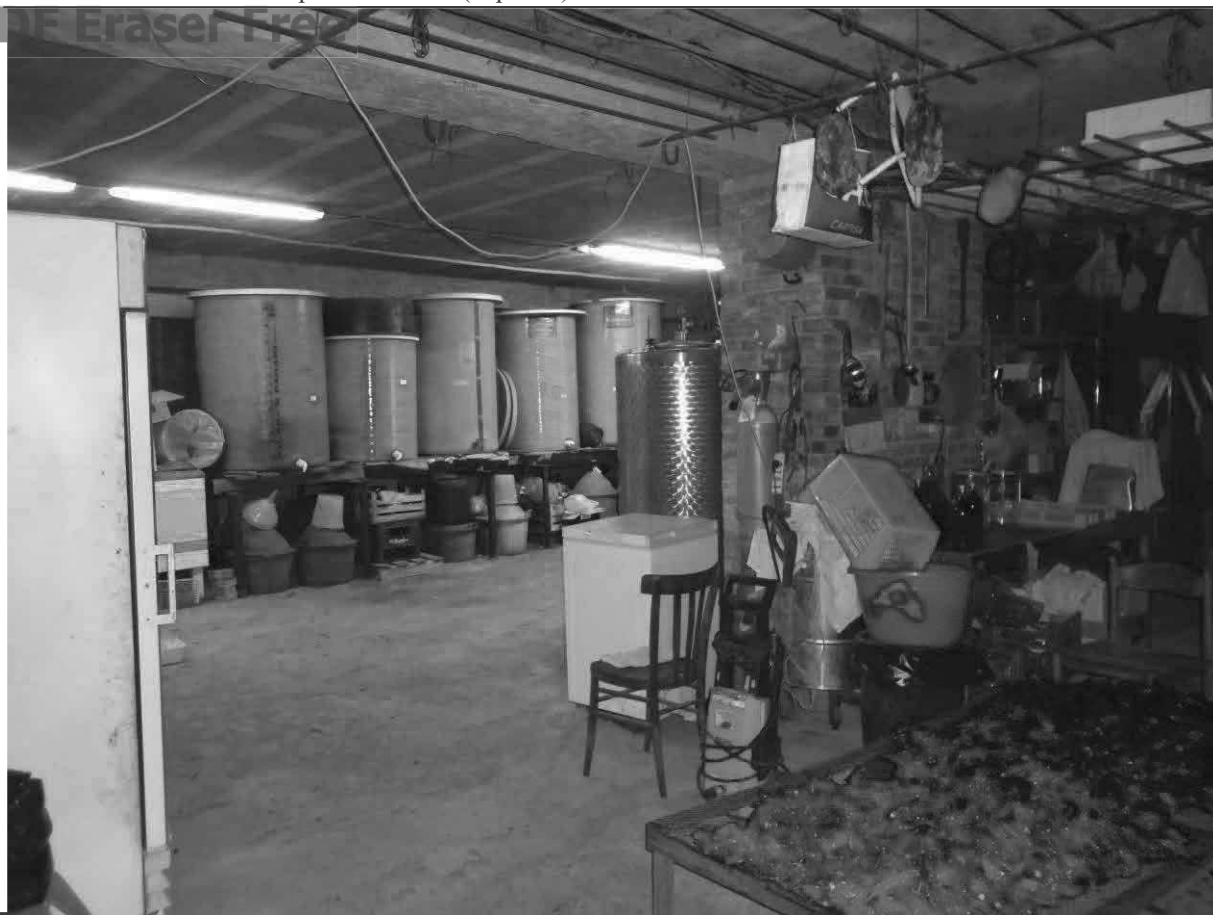
FOTOGRAFIA N.7: Vista piano interrato (deposito)
