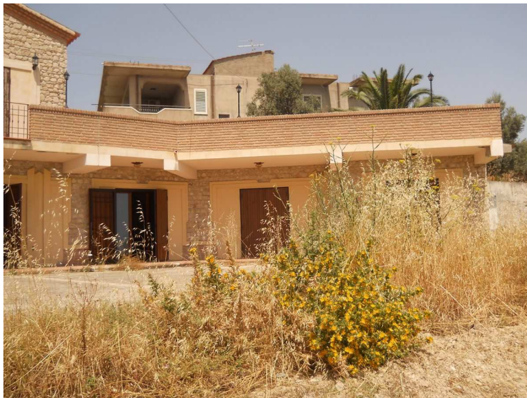
Foto n. 2 – Prospetto anteriore e terrazzo esterno piano terra
