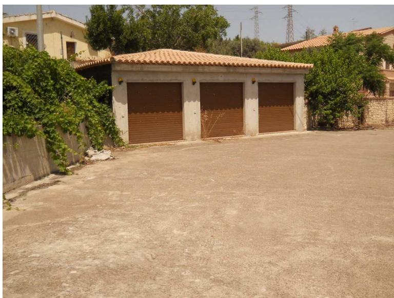
Foto n. 24 – Garage e deposito
