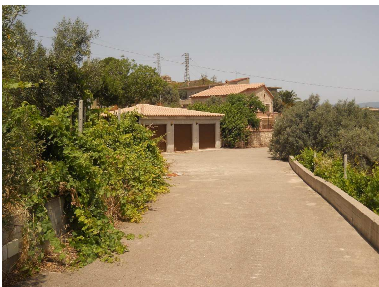
Foto n. 25 – Immobili oggetto di procedura d'esecuzione
