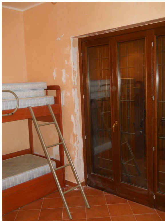
Foto n. 21 – Camera da letto piano terra
