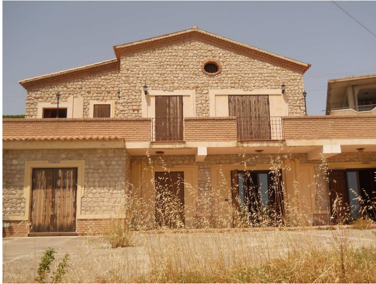
Foto n.1 – Prospetto anteriore dell'immobile
