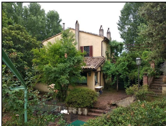
Vista esterna – nord
