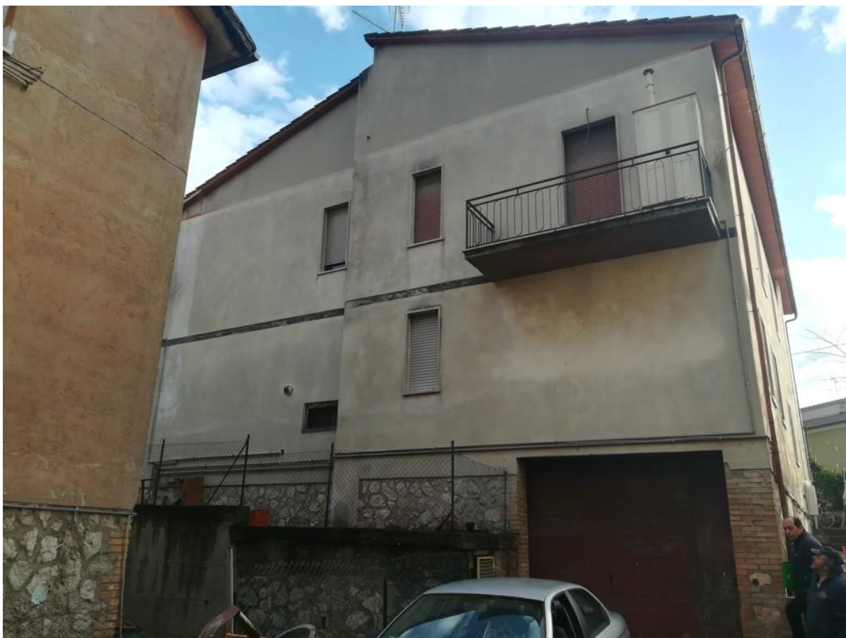
(INTERO EDIFICIO, vista generale esterna)
