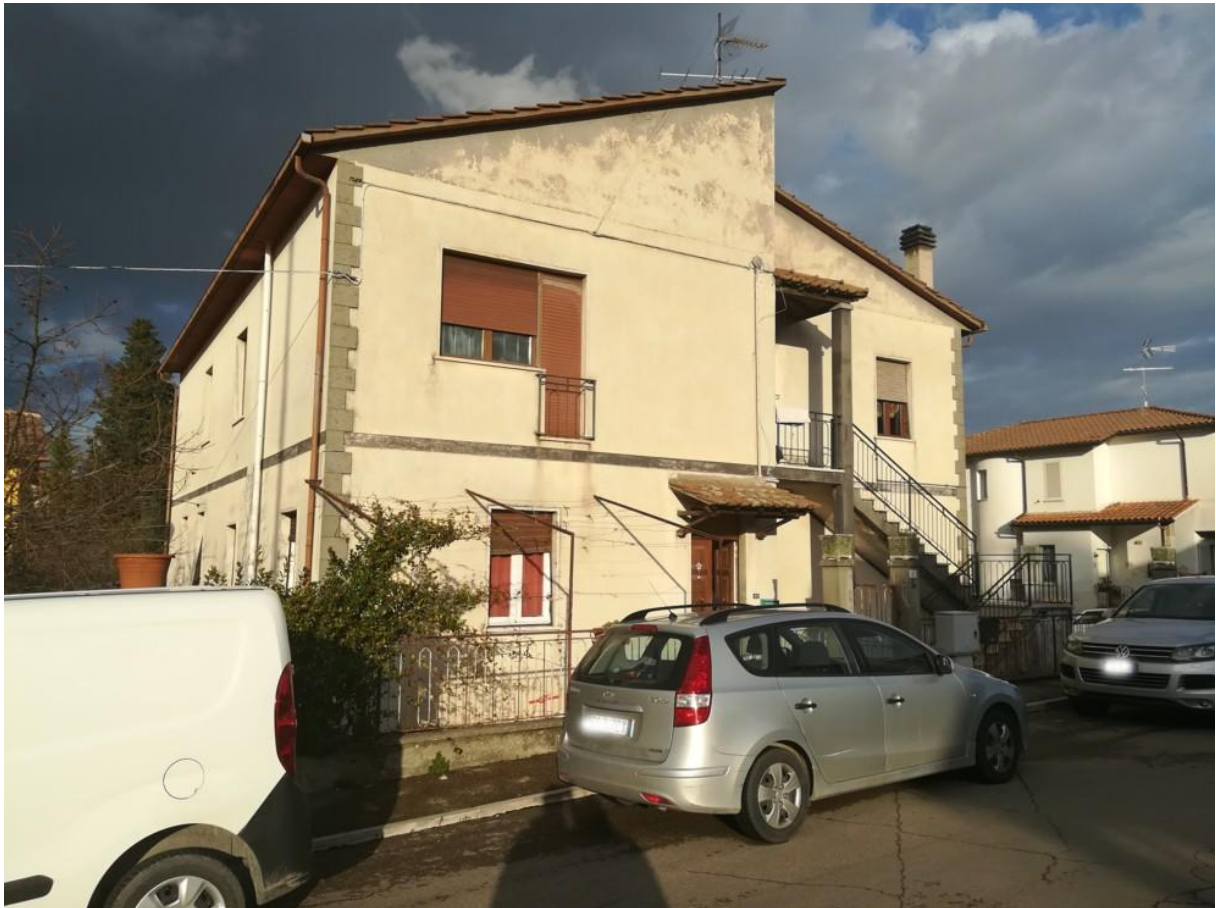
(INTERO EDIFICIO, vista generale esterna)
