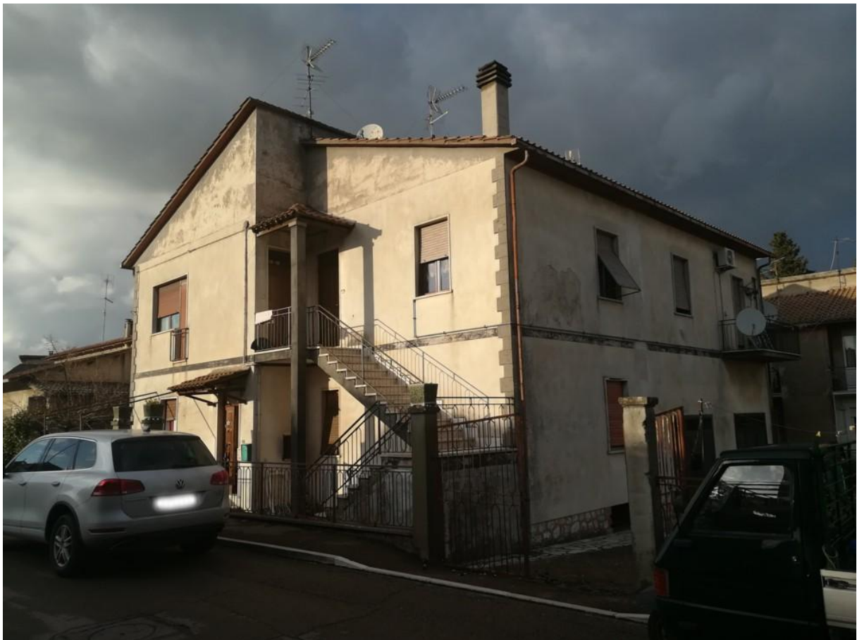
(INTERO EDIFICIO, vista generale esterna)
