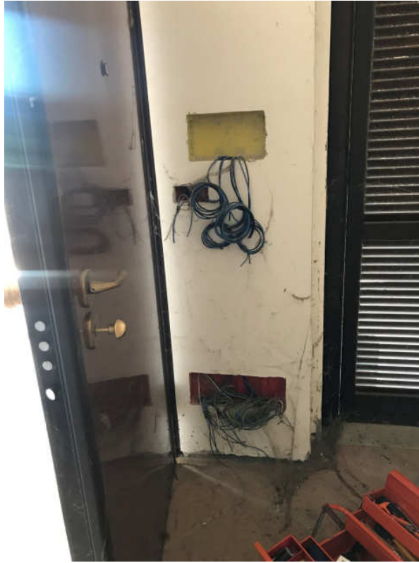
particolare quadro elettrico
