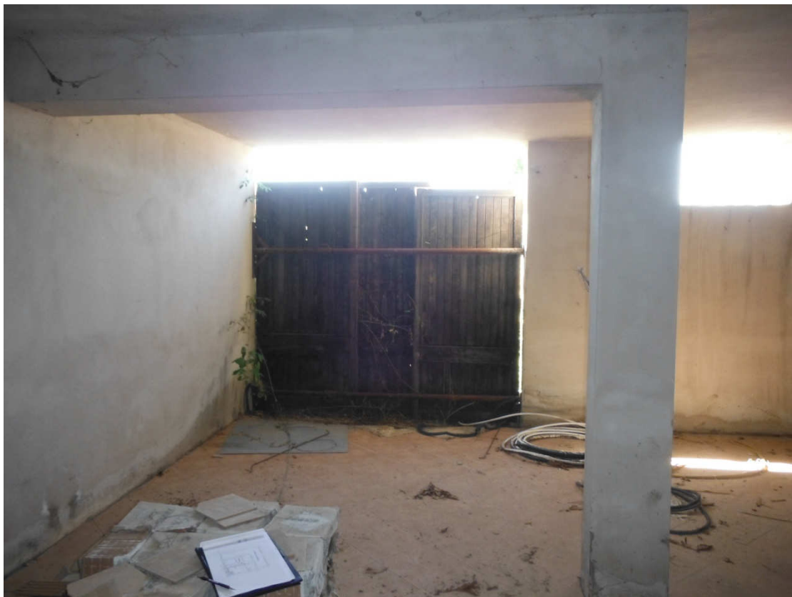
accesso esterno del piano interrato
