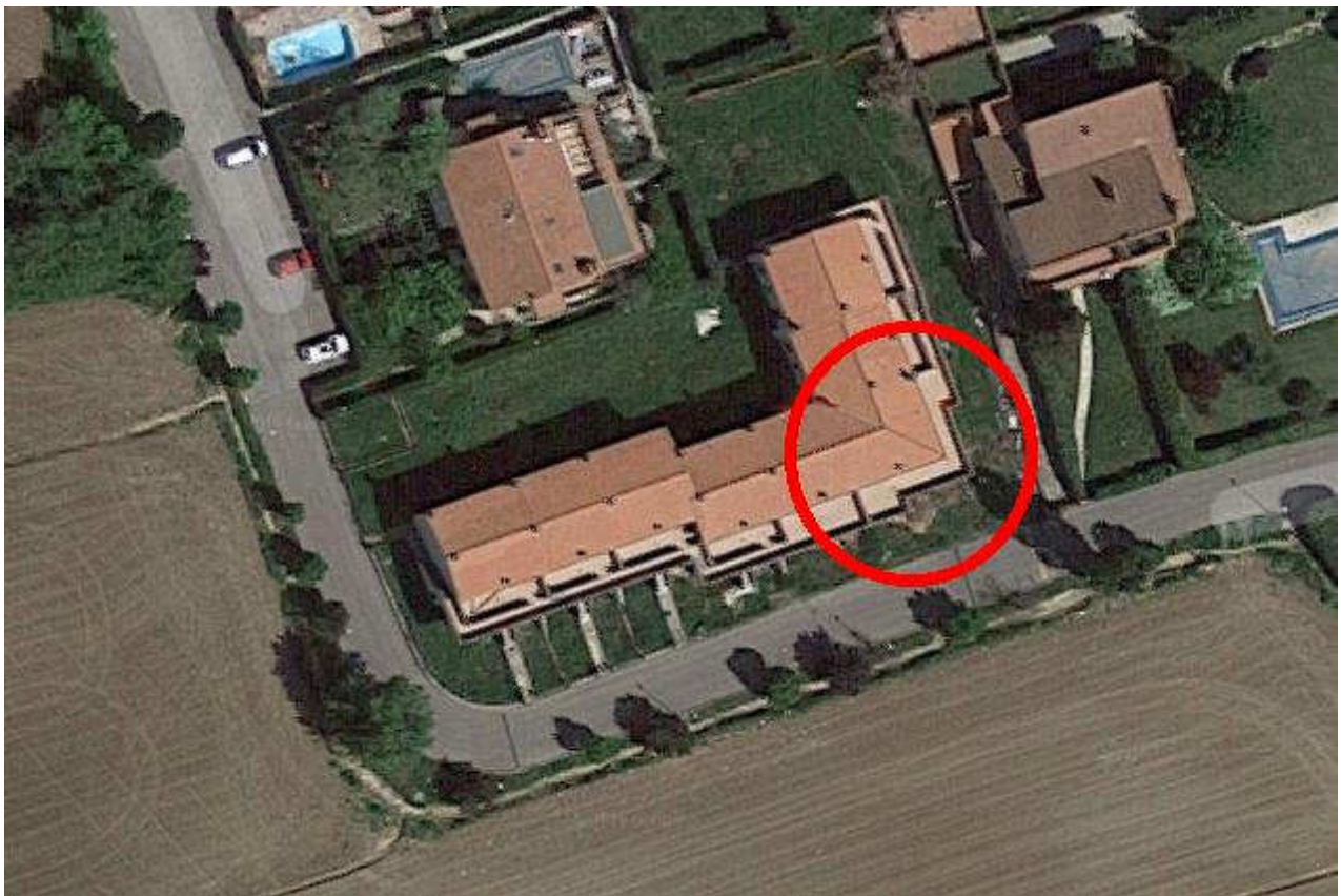
visione aerea del fabbricato
