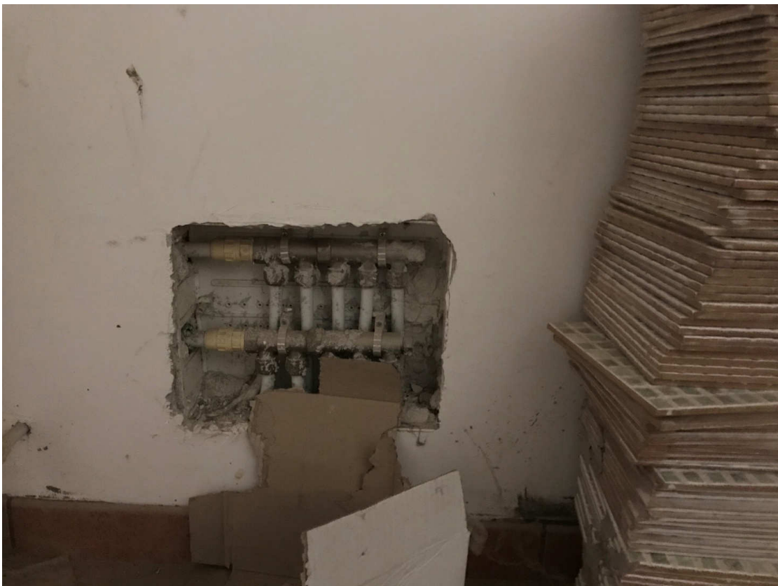
particolare collettore riscaldamento
