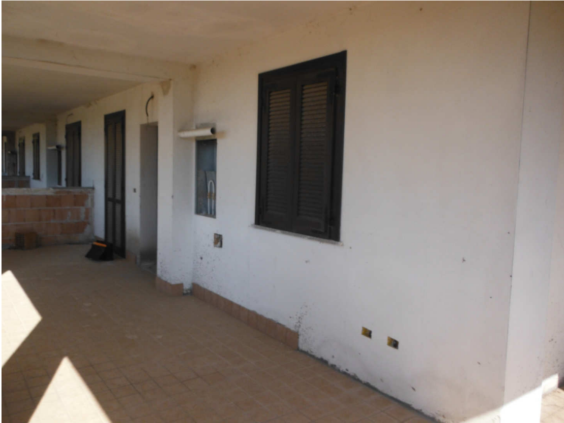
facciata ingresso piano terra
