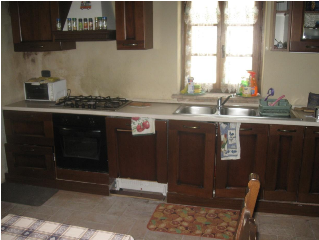
Foto 09 Interno Cucina Piano Terra
