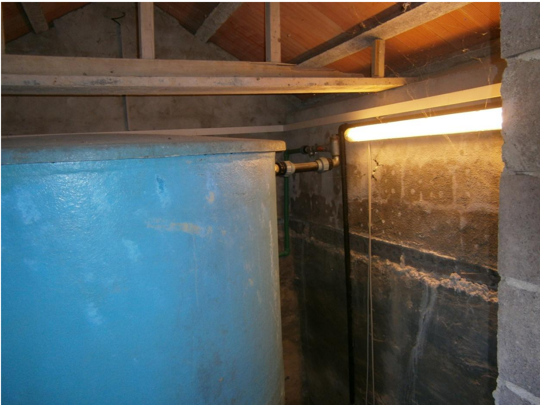
Foto 06 Interno Serbatoio Acqua
