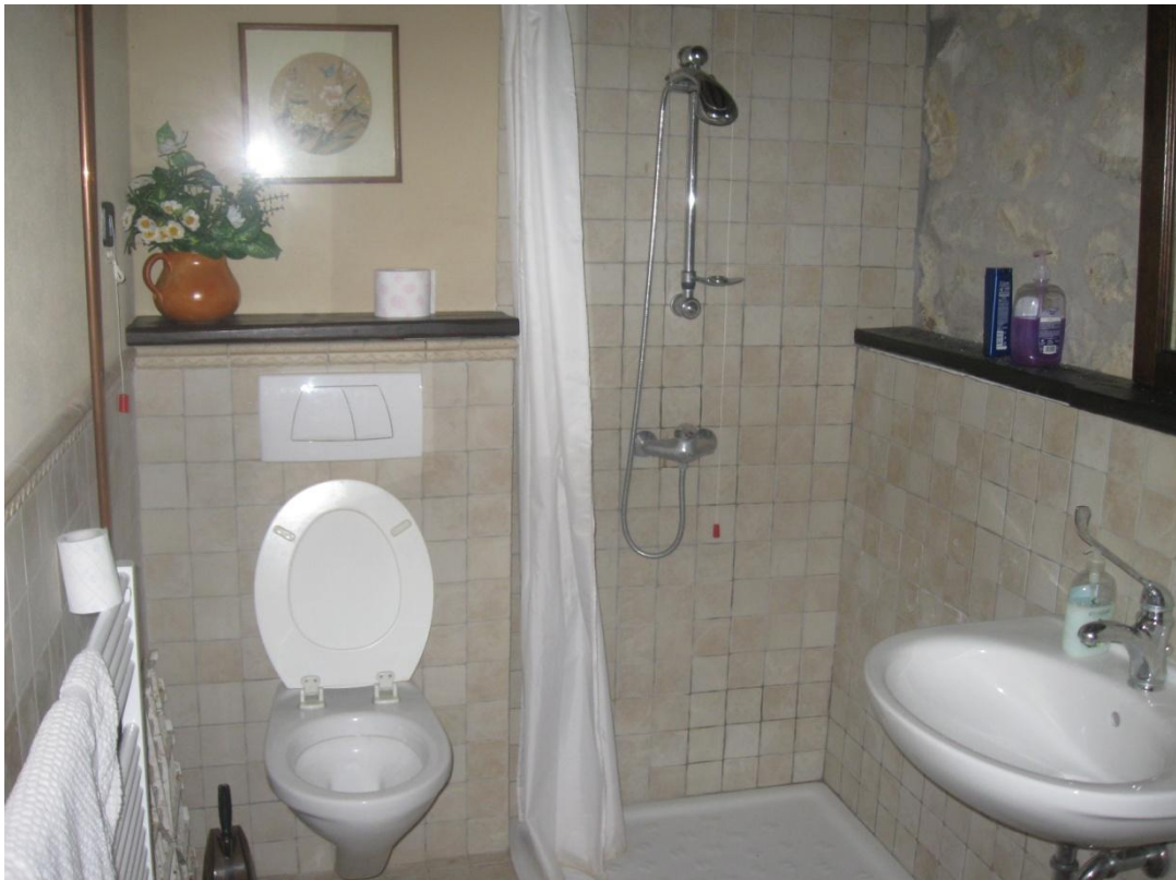
Foto 10 Interno Bagno tipo
