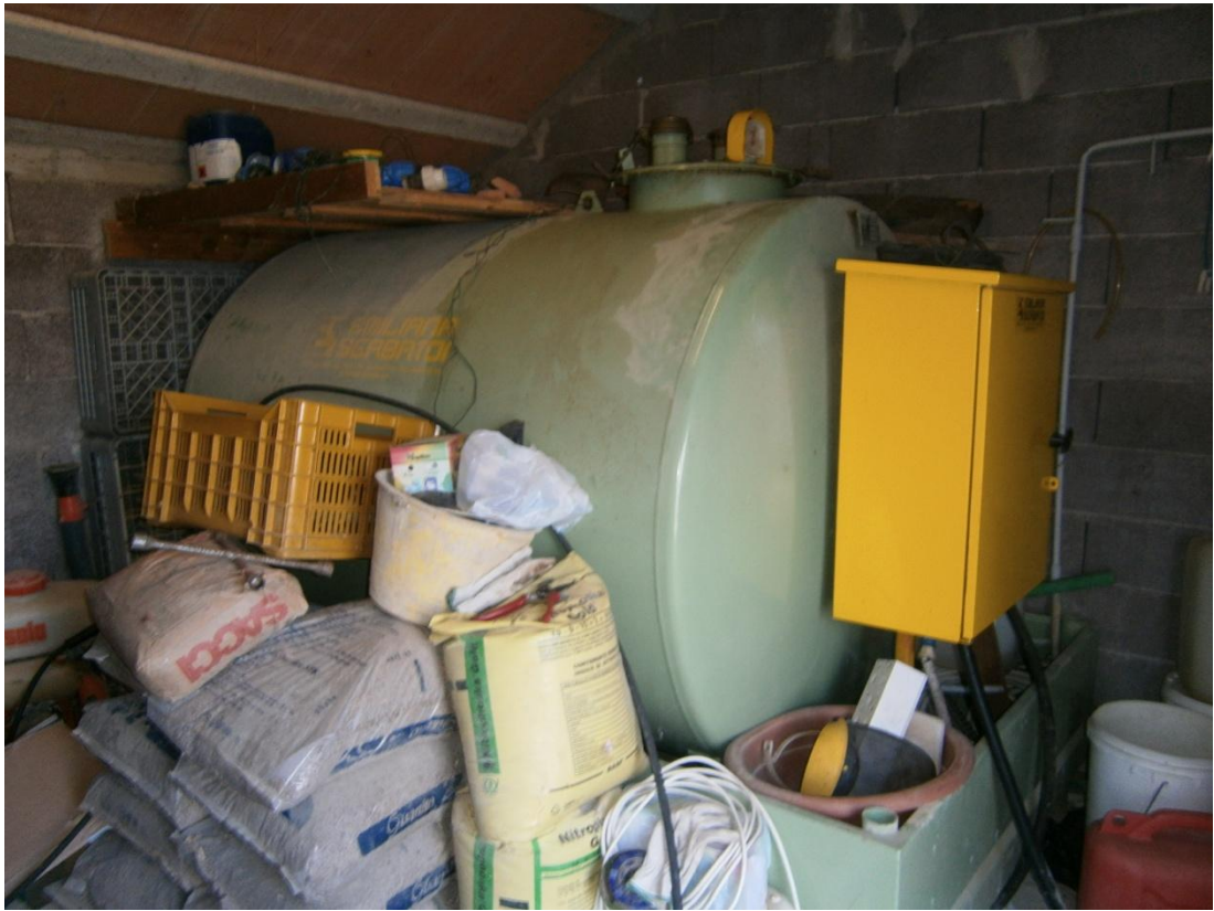
Foto 05 Interno Serbatoio Gasolio
