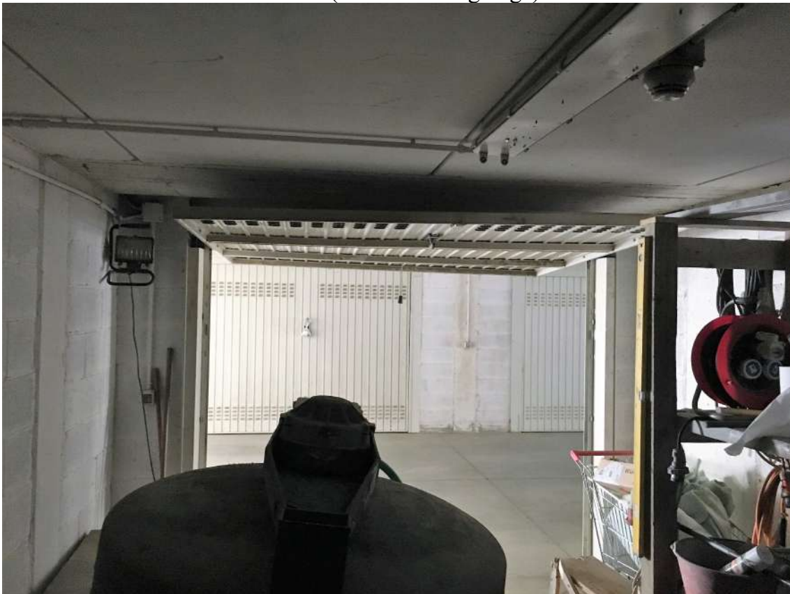
P.V. 44 (Vista interno garage)
