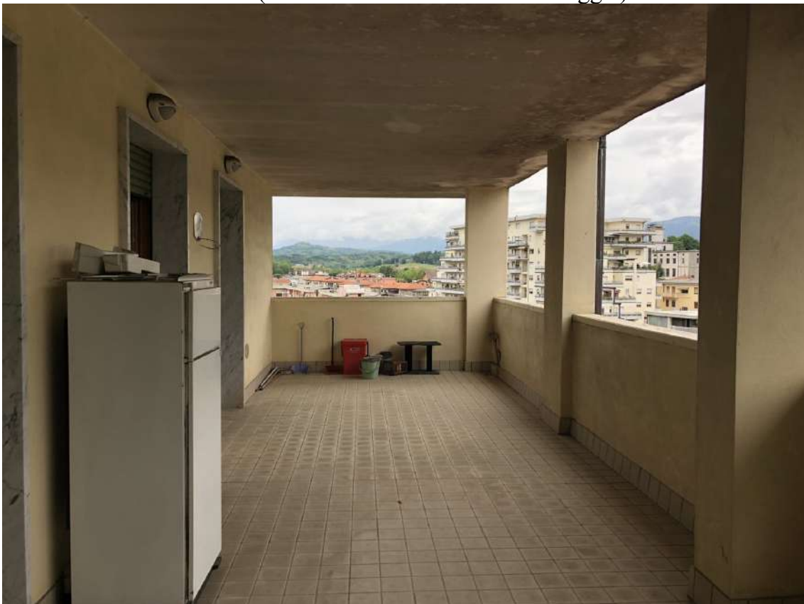
P.V. 16 (Vista interno lastrico solare a loggia)
