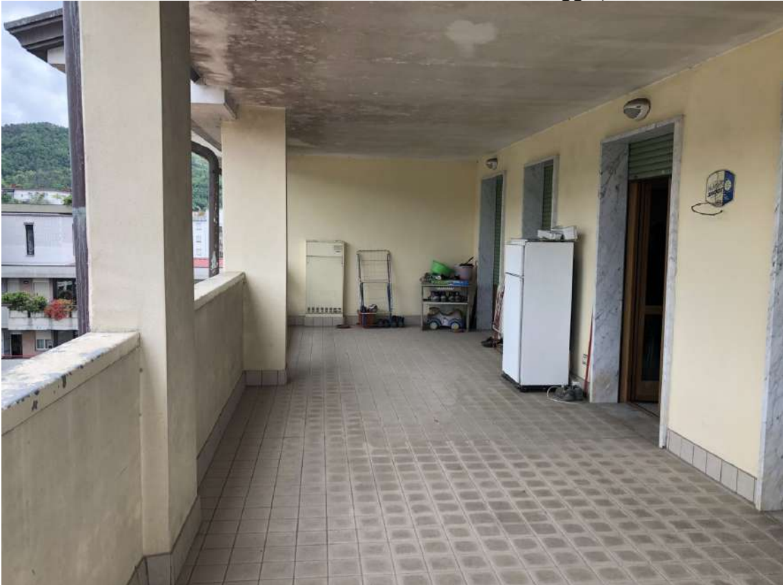
P.V. 17 (Vista interno lastrico solare a loggia)
