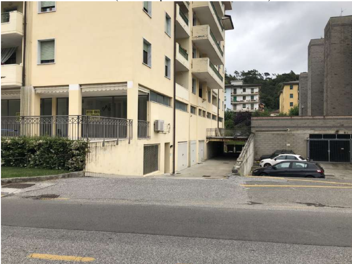
P.V. 04 (Vista rampa di accesso all'interrato)
