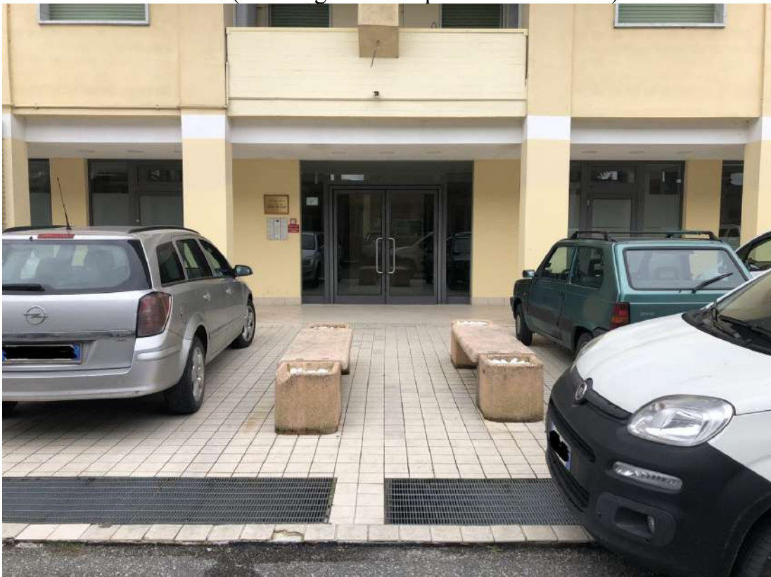
P.V. 06 (Vista ingresso complesso immobiliare)
