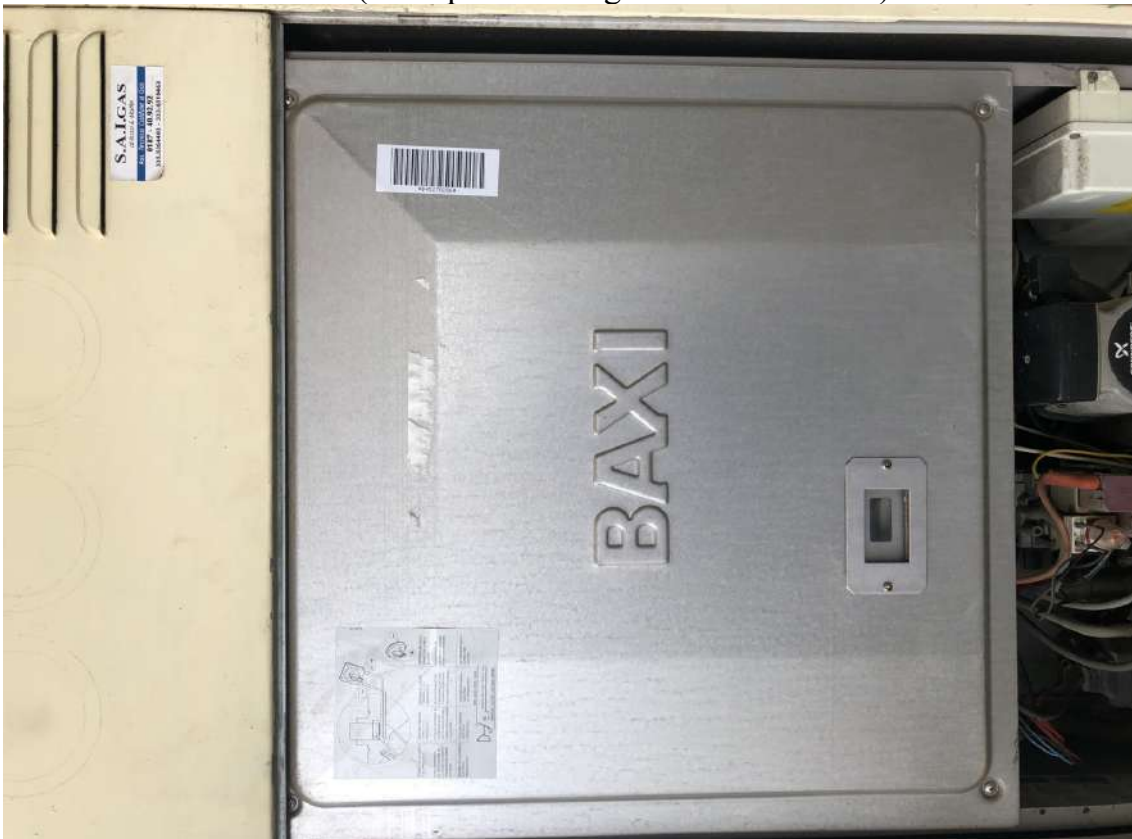
P.V. 40 (Vista particolare generatore di calore)
