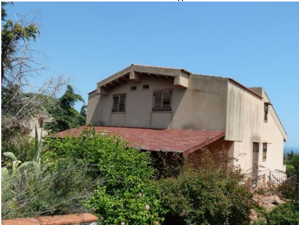
vista sud dell'immobile
