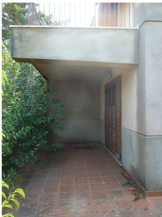
portico sotto terrazzo lato nord
