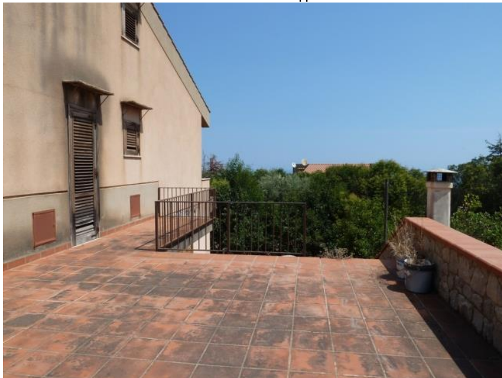
ballatoio sul prospetto est
