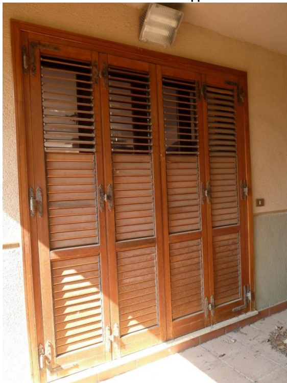
apertura al piano terra sotto il portico a nord
