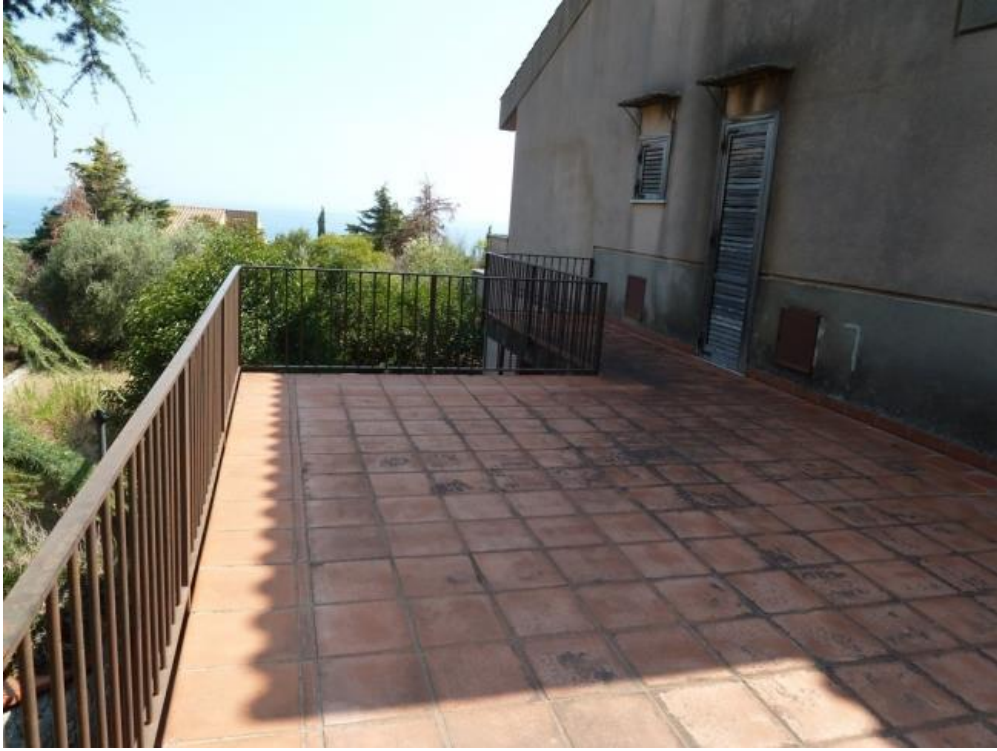
ballatoio 1p. lato ovest
