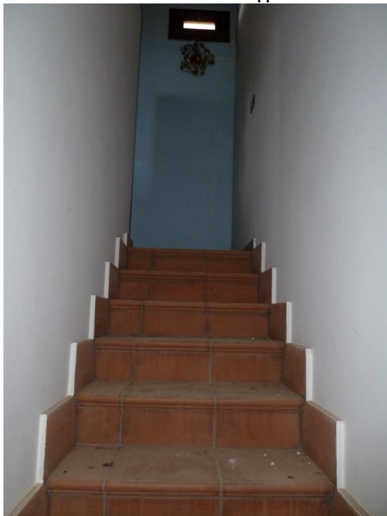
rampa di scala per accedere al 2p.
