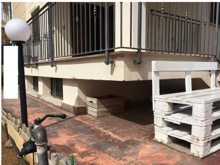
*Foto n. 10 – Immagini relative al retro – prospetto ove si evince l'avanzamento di parte delle finestre del seminterrato che da progetto approvato avrebbe dovute essere a filo del muro interno dell'indiana.*
