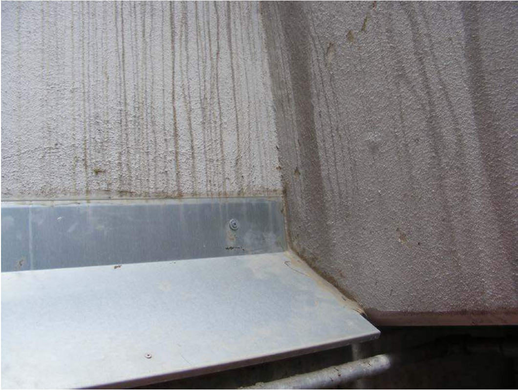
Figura 52: Laterale della trave ben sigillato
