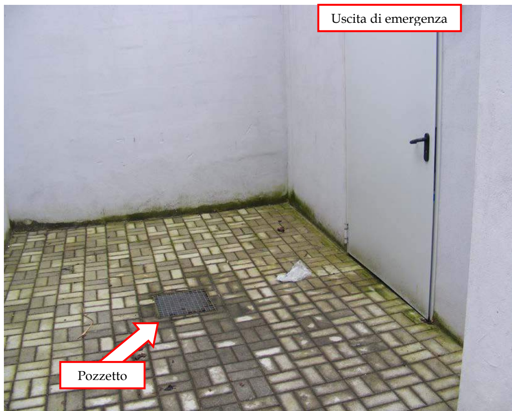
Figura 44: L'area di sbarco dall'uscita di emergenza
