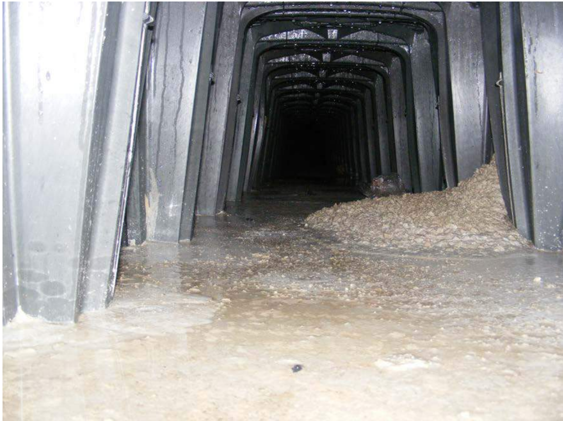
Figura 63: Il vespaio di altezza “ridotta” nelle zone giardinate
