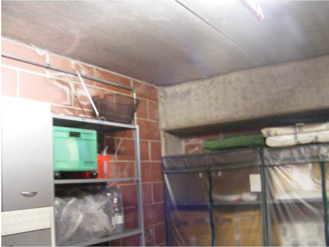
Figura 58: I danni all'interno del box adiacente
