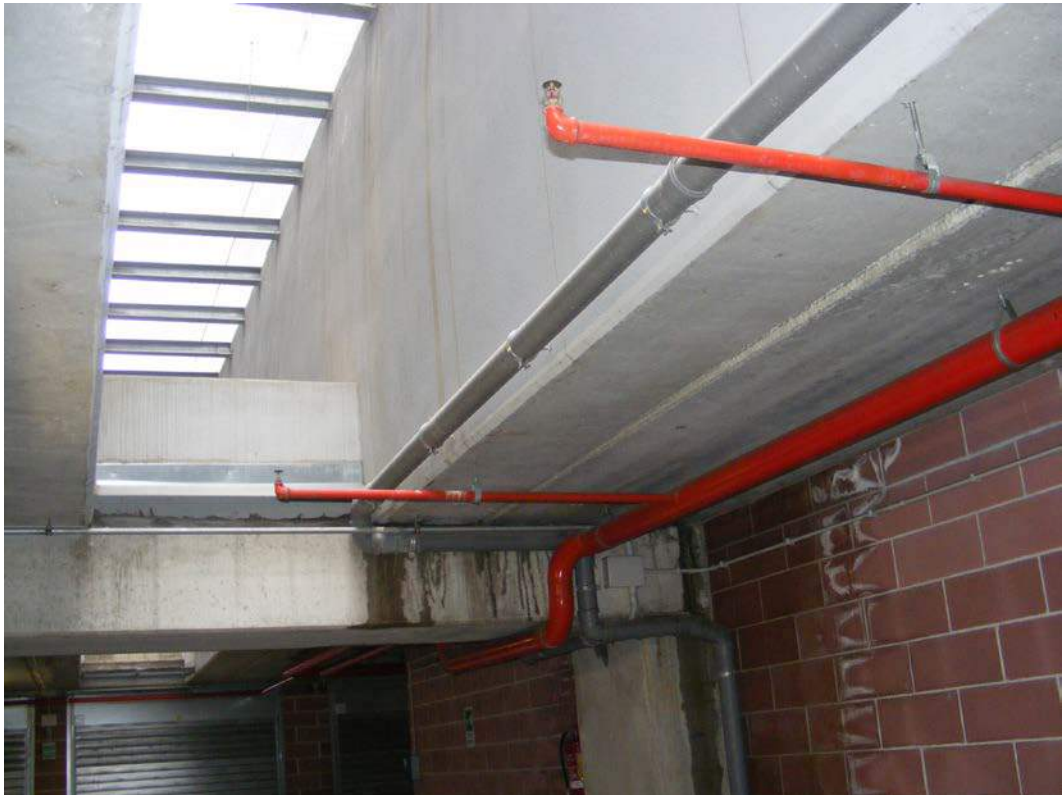
Figura 57: Vista della griglia, della trave ed i danni dall'esterno per l'acqua proveniente dal "bacino".
