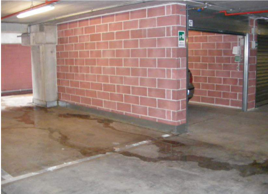
Figura 36: Le acque che invadono le aree dei posti auto che fanno da copertura dei box al piano inferiore)
