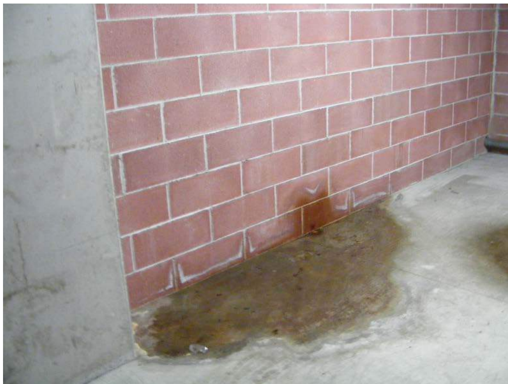
Figura 11:Acqua al piede di una parete divisoria che invade il box limitrofo e risale.
