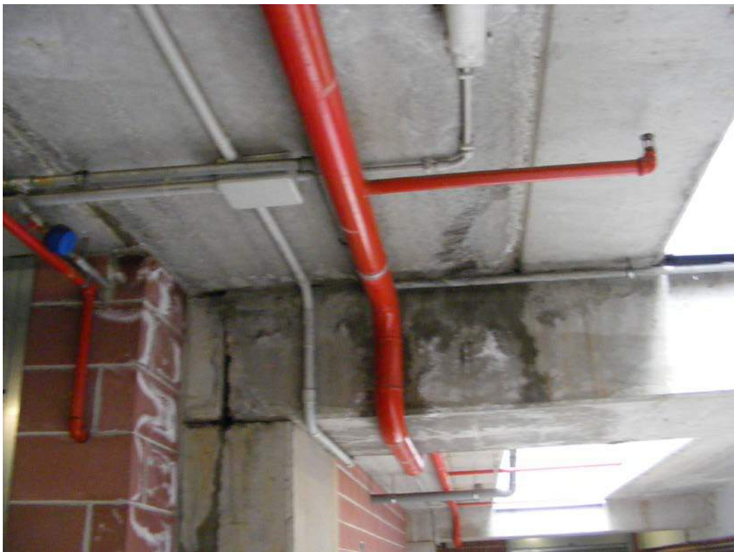
Figura 55: In sinistra il pilastro e le infiltrazioni al box ed in destra la griglia di ventilazione.
