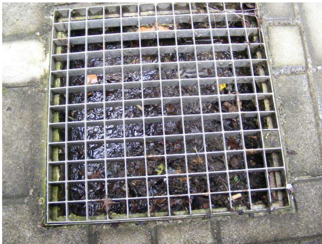
Figura 45: Pozzetto ostruito e acqua ristagnante fin oltre la metà delle tubazioni.
