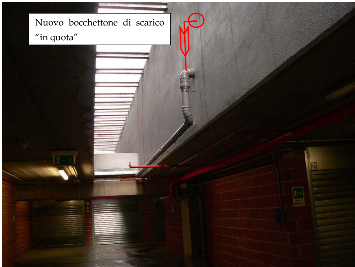
Figura 66: Schema di connessione alla rete di scarico esistente
