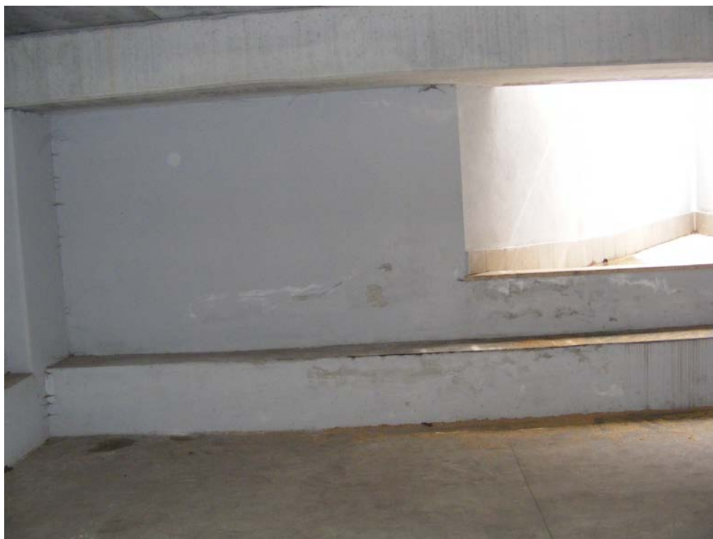
Figura 9: Parete dell'area di manovra posta al piede di un giardino pensile e un camino di ventilazione
