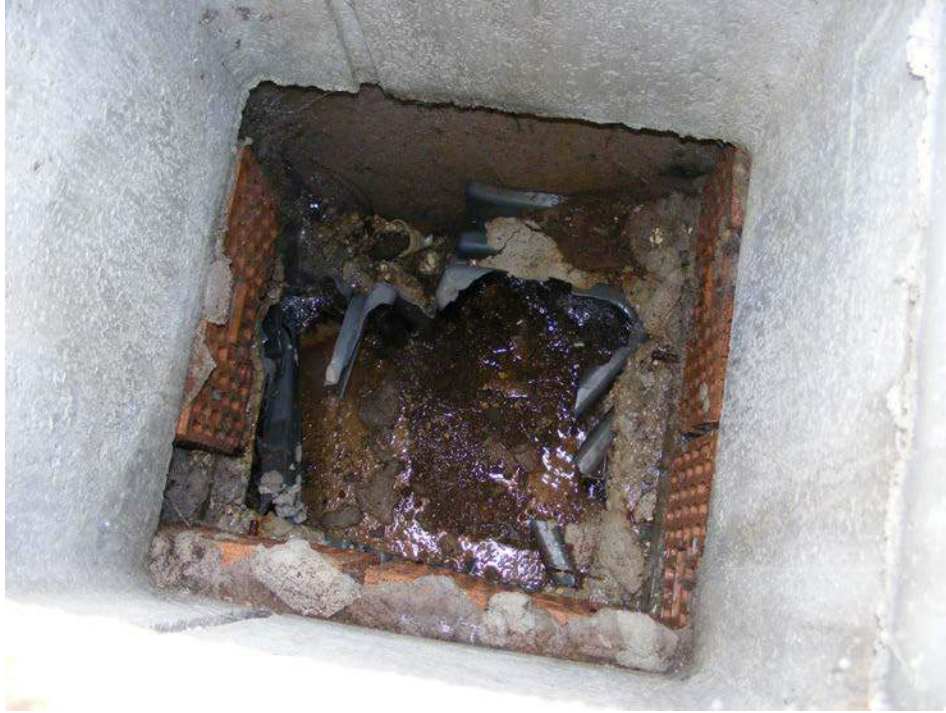
Figura 21: Pozzetto di scarico
