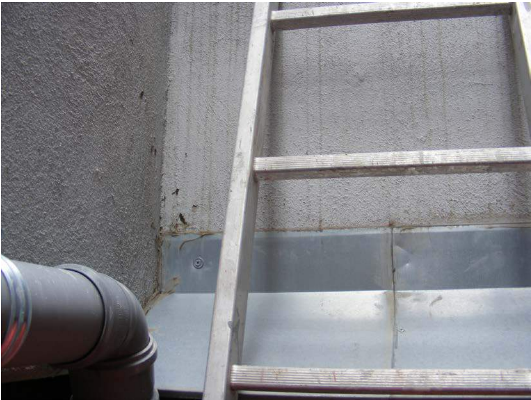
Figura 53: Particolare della scossalina anch'essa ben sigillata.
