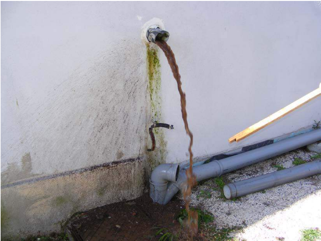
Figura 42: Il bocchettone di scarico
