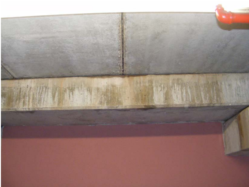
Figura 37: Le venute di acqua al piano inferiore. Autorimessa 5 Box 47
