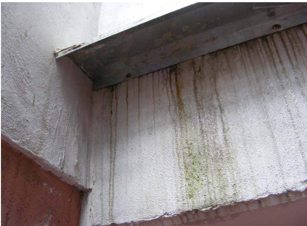
Figura 29: Perdita all'interfaccia solaio parete
