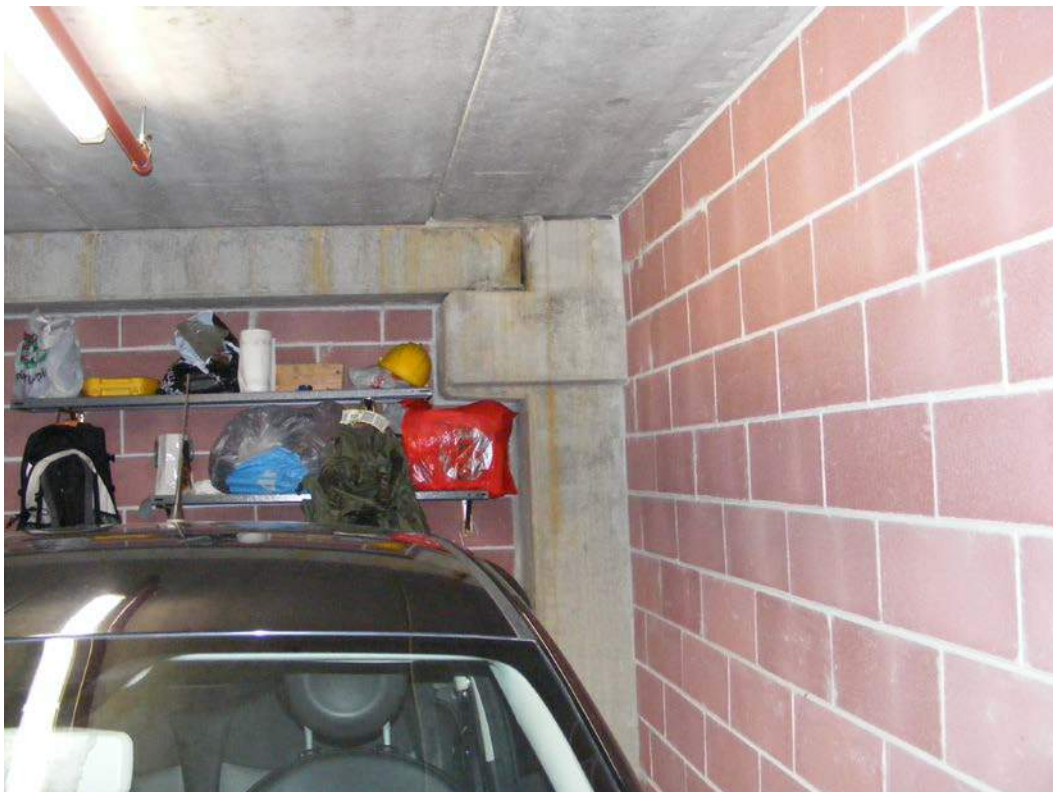
Figura 47:Le infiltrazioni dal solaio dovute alla ventilazione del piano superiore
