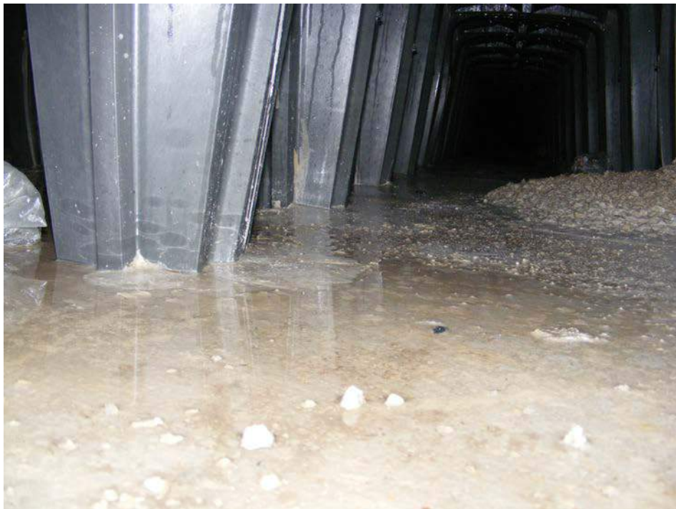
Figura 22: Vespaio con ristagno di acqua
