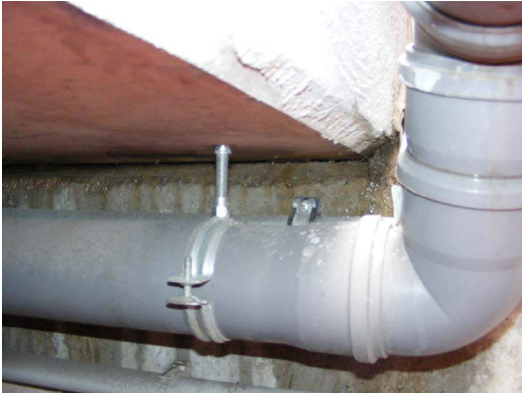
Figura 54: Le venute dal solaio in corrispondenza della trave
