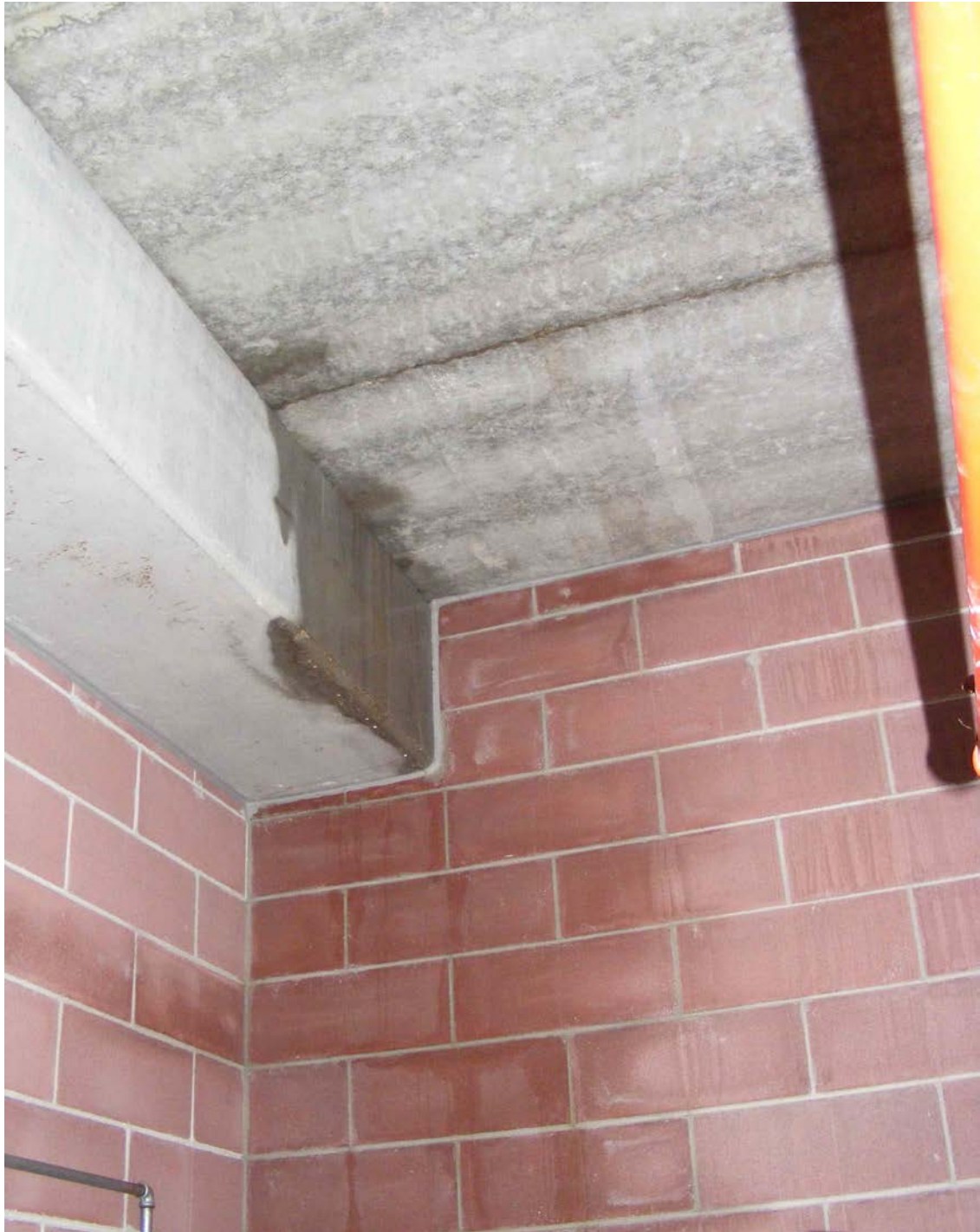
Figura 6: Venuta in corrispondenza dell'appoggio del solaio con infiltrazioni nel muro
