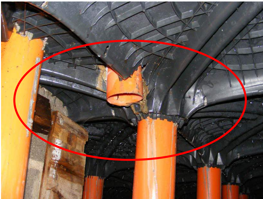
Figura 61: Vista dall'interno del vespaio del tubo di scarico proveniente dalla canaletta
