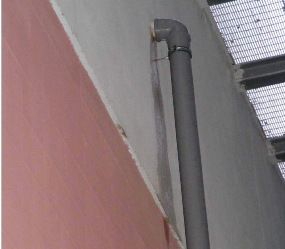
Figura 28: Perdita dal foro di alloggiamento del bocchettone
