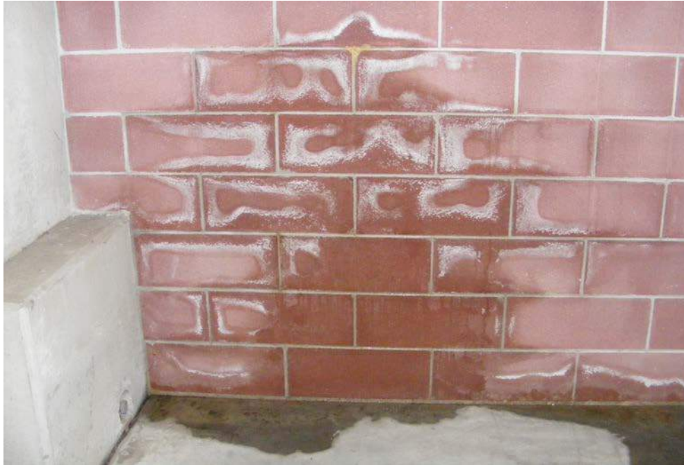
Figura 24: Autorimessa 2, posti auto lato rampa, venuta dal solaio a tergo della parete.
