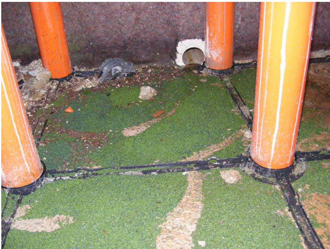
Figura 62: Bocchettone di scarico delle acque del vespaio a ridosso della parete perimetrale
