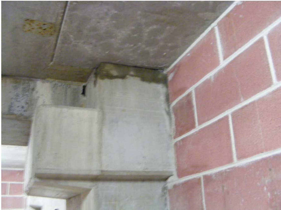
Figura 38: Le venute di acqua al piano inferiore. Autorimessa 5 Box 47
