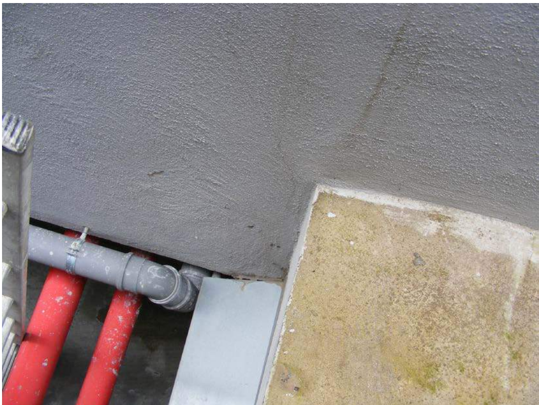
Figura 51: Laterale della trave ben sigillato.
