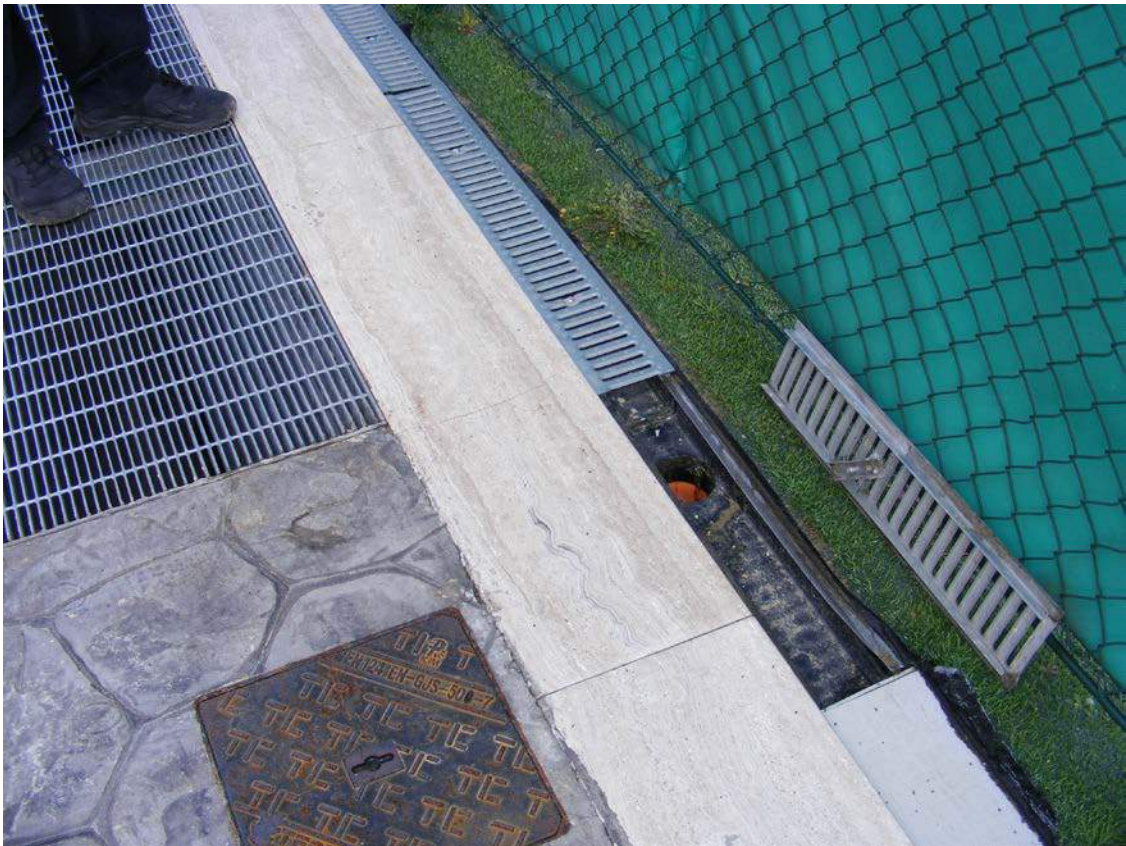
Figura 60: Canaletta di raccolta, tubo di scarico
