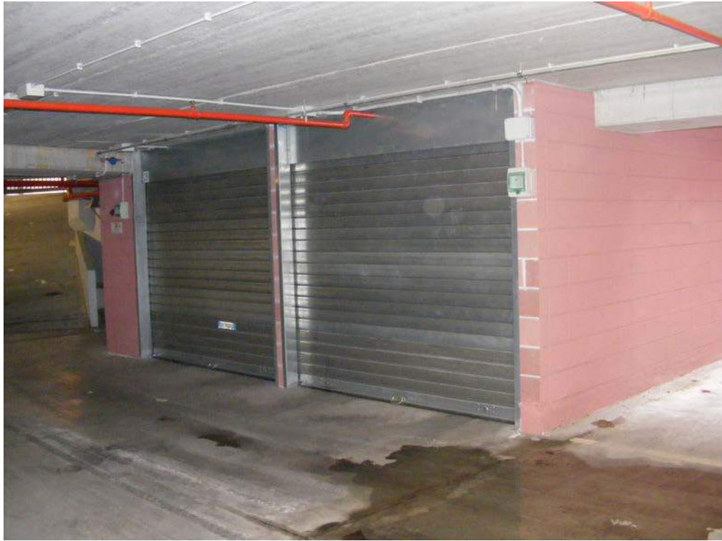
Figura 13: Ristagno di acqua davanti ad uno dei box segnalati
