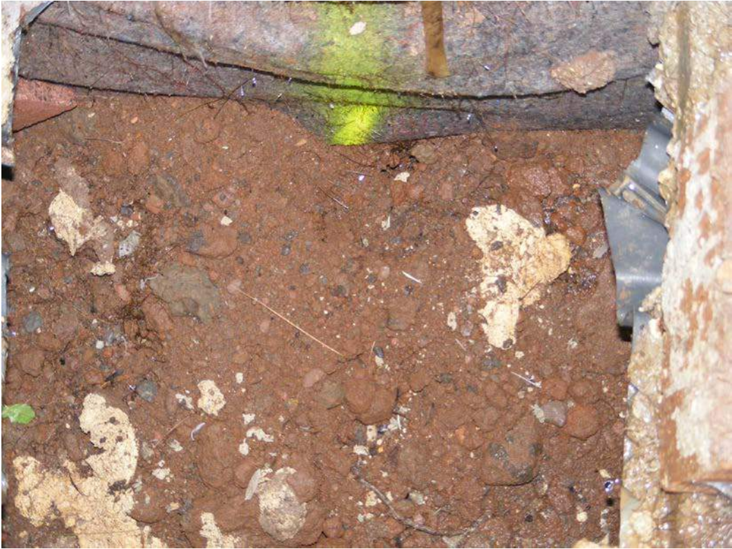
Figura 41: Uno dei pozzetti nel giardino a ridosso della rampa di Villa Paola colmo di terreno
