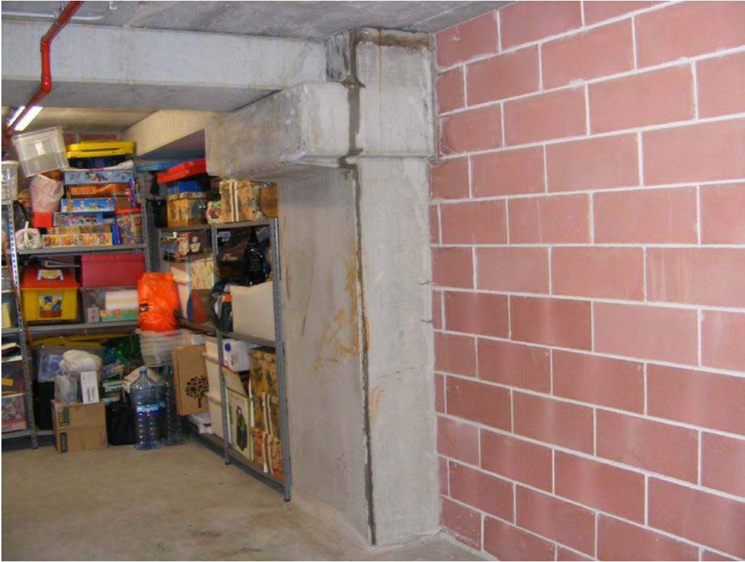
Figura 40: Le venute di acqua al piano inferiore. Autorimessa 5 Box 49
