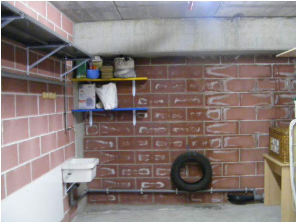
Figura 7: Parete di fondo di uno dei box posta a ridosso della palificata.
