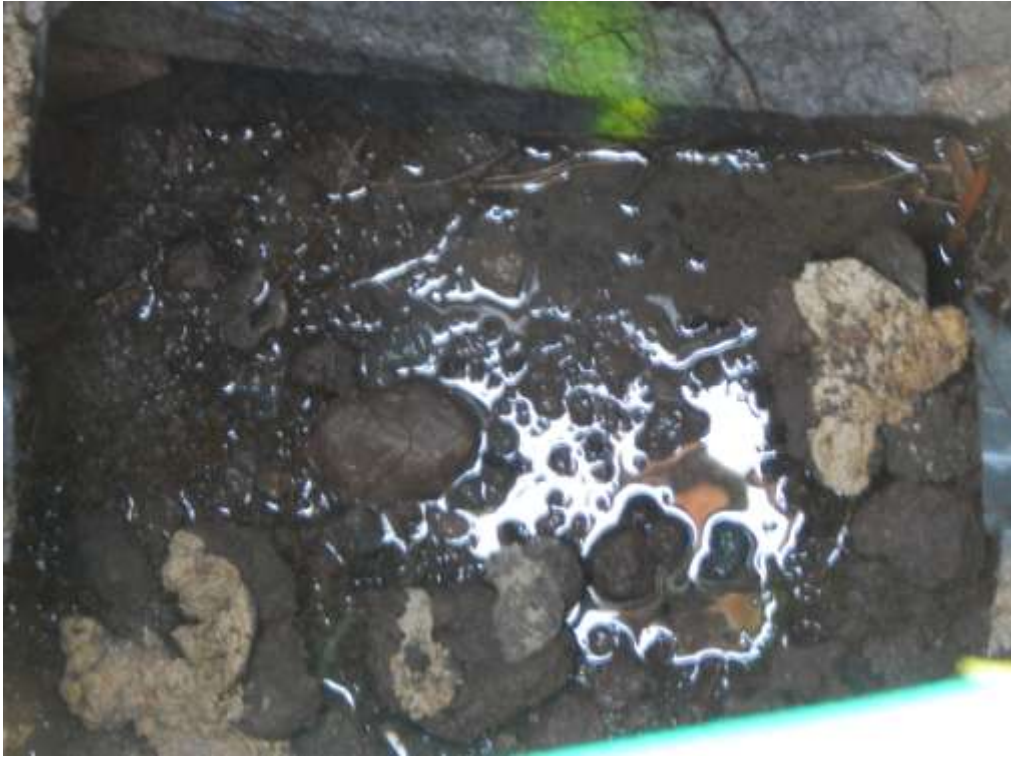
Acqua che permane nel pozzetto (4749)
