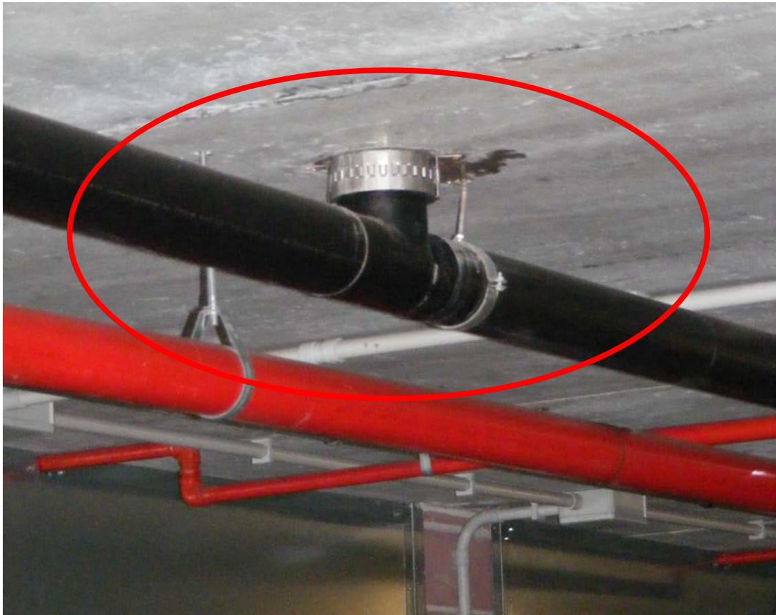
Figura 67: Vista dello scarico della canaletta del piano superiore e tubazione di convogliamento
