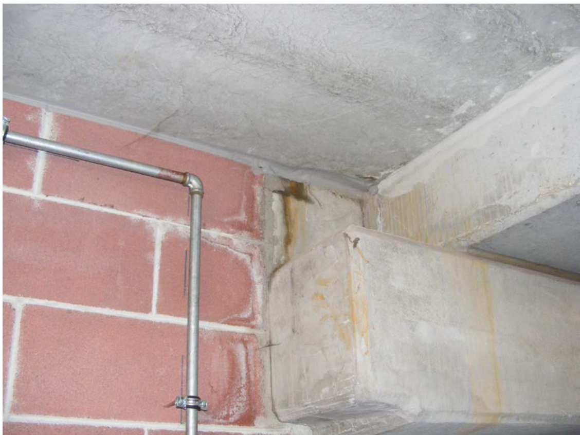
Figura 39: Le venute di acqua al piano inferiore. Autorimessa 5 Box 48
