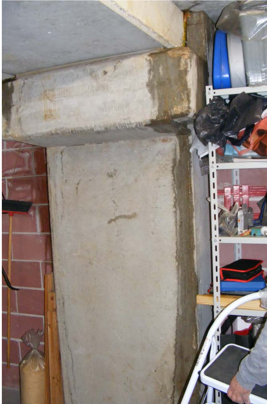
Figura 26: Autorimessa 5 Box 09. Infiltrazione lungo il pilastro
