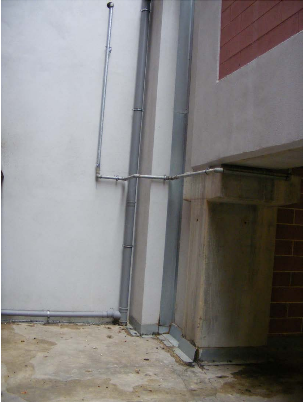
Figura 35:Le acque al piede della dell'intercapedine di ventilazione
