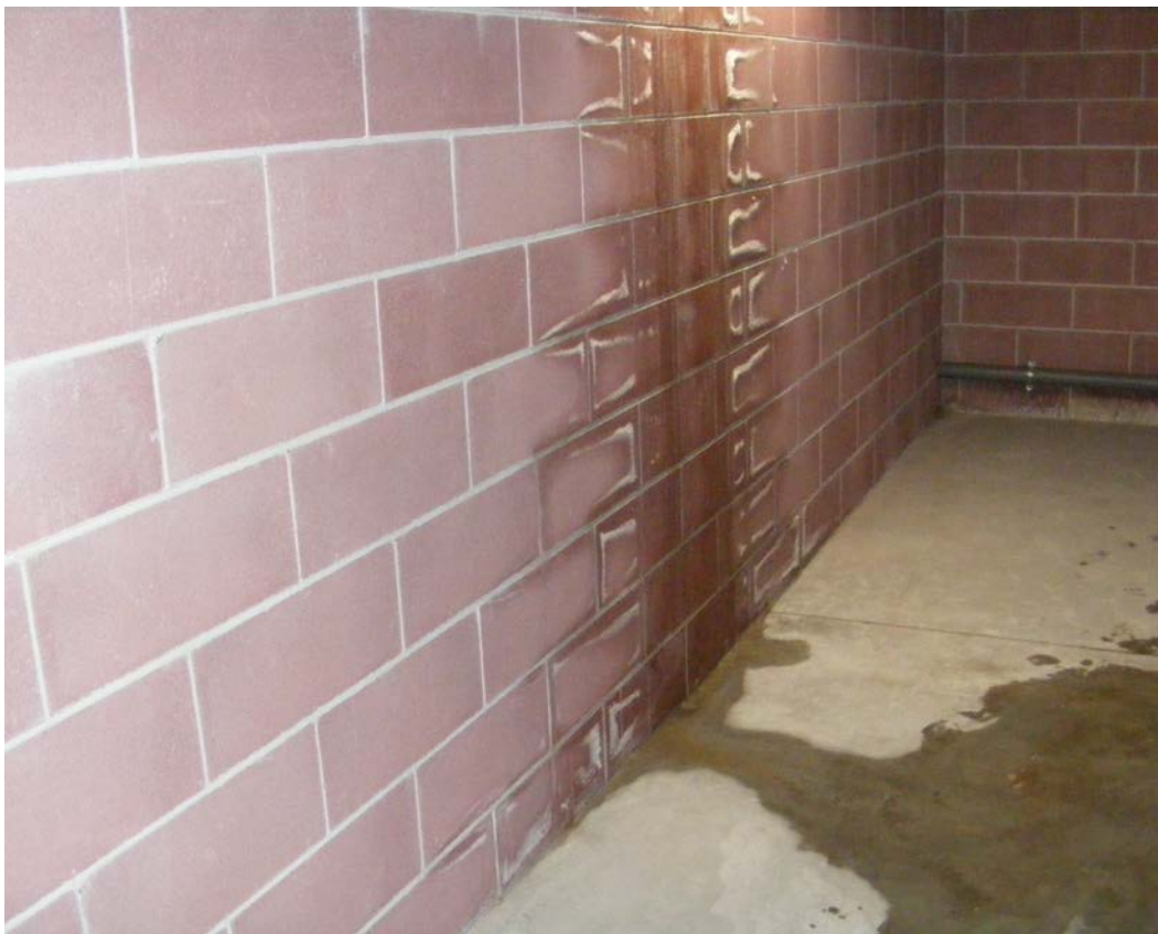
Figura 4: Cospicua venuta dal piano superiore in corrispondenza del pilastro
