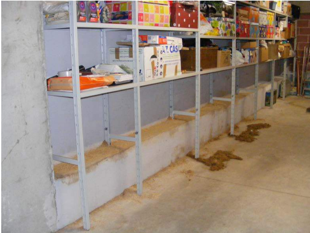
Figura 10: Parete di un box posto al piede di un giardino pensile e un camino di ventilazione
