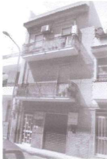
Fabbricato via Nazionale SS113 Scala Torregrotta (Me)
