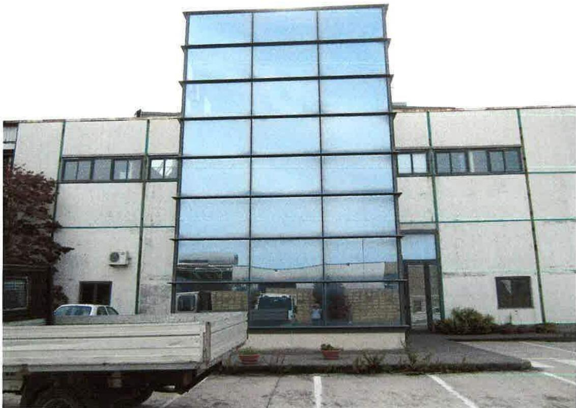
Foto 21: vista frontale del corpo scala, in appendice al capannone, perimetrato da una pannellatura a vetri, realizzato in diffornità al progetto approvato
