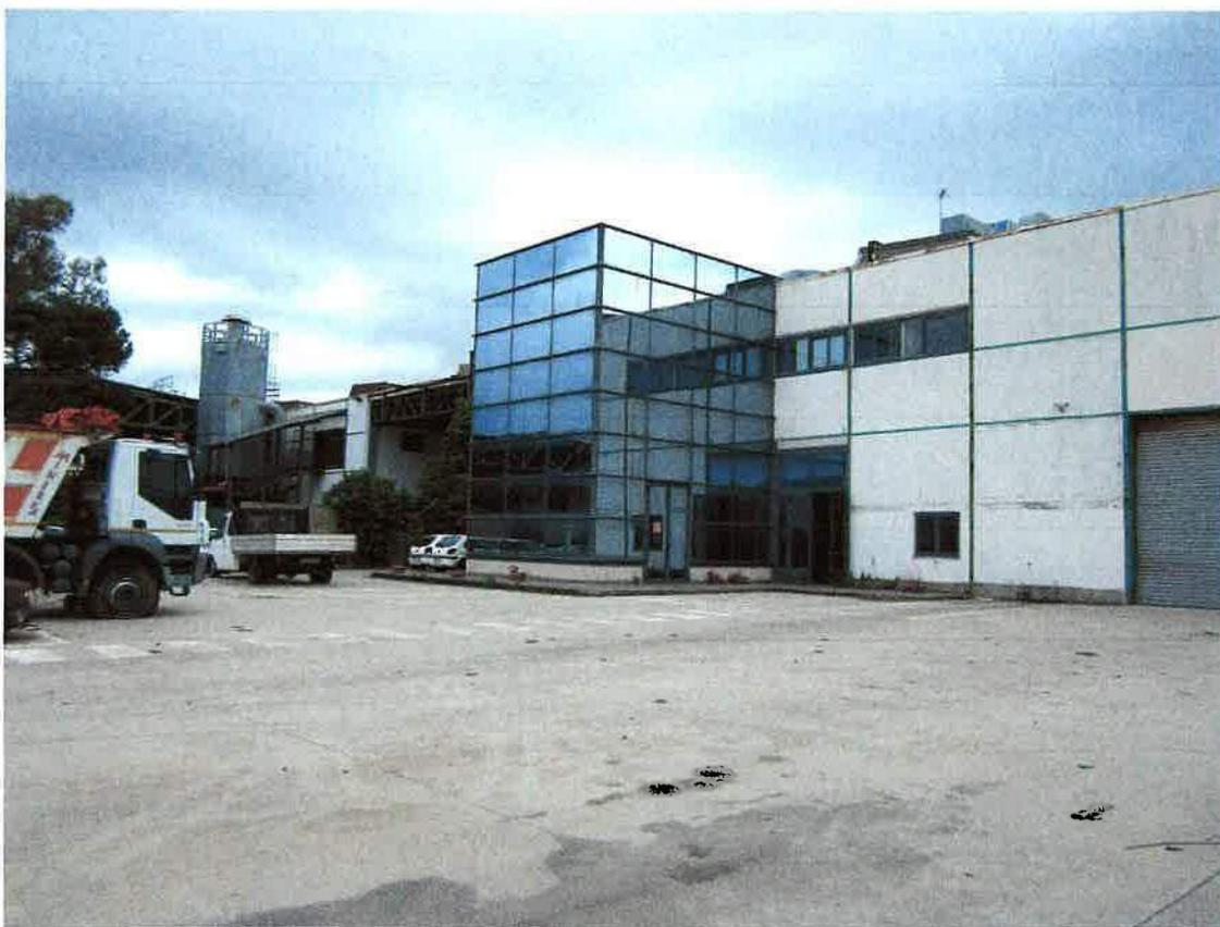
Foto 5: panoramica, in direzione sud-est, dell'area esterna di pertinenza, antistante il capannone; al centro della foto il corpo scala, in appendice al capannone, perimetrato da una pannellatura a vetri, realizzato in difformità al progetto approvato
