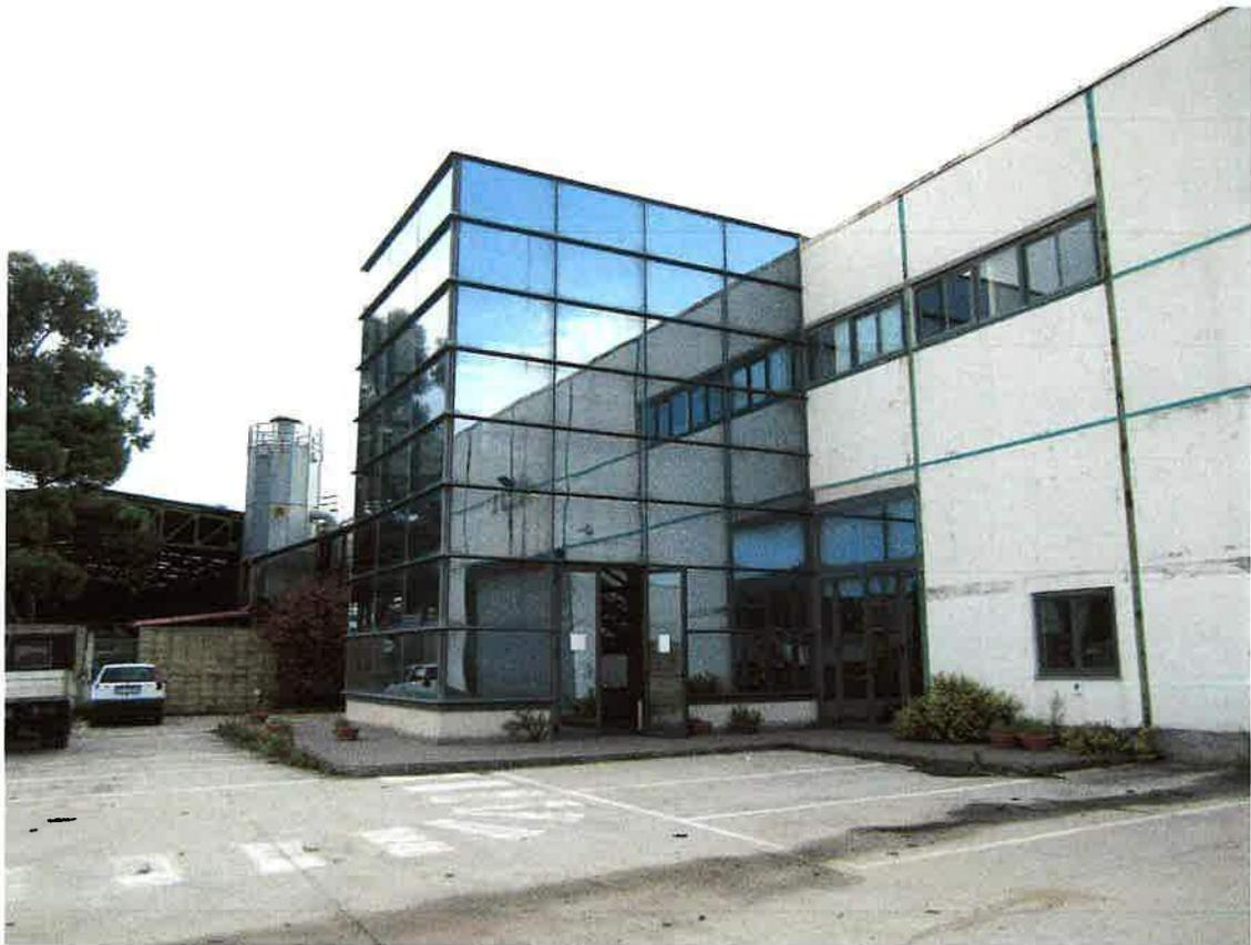
Foto 20: vista laterale del corpo scala, in appendice al capannone, perimetrato da una pannellatura a vetri, realizzato in diffornità al progetto approvato, che conduce al piano che ospita gli uffici
