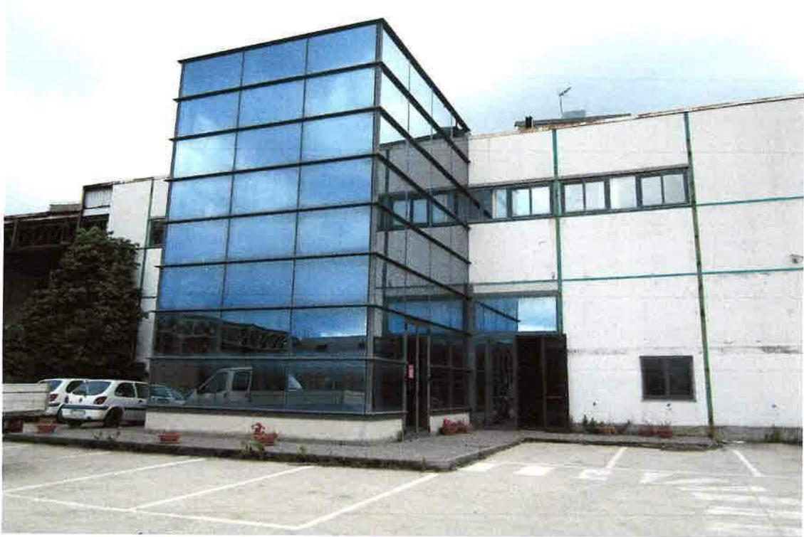
Foto 6: particolare del corpo scala, in appendice al capannone, perimetrato da una pannellatura a vetri, realizzato in difformità al progetto approvato
