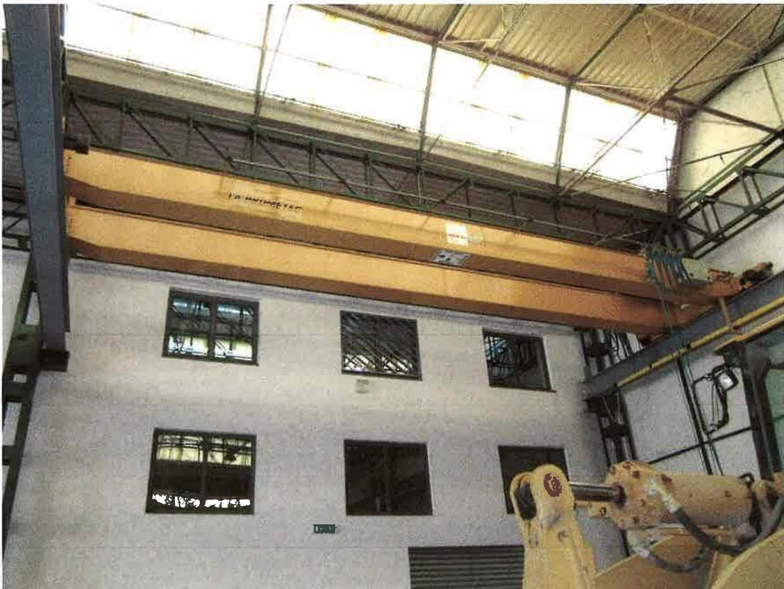
Foto 13: il carroponte con portata da 5 tonn. a servizio del capannone
