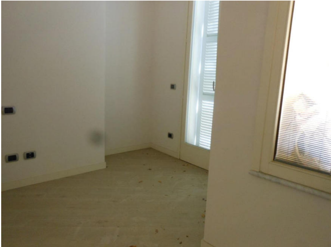
Foto 13 Camera alloggio sub.20
