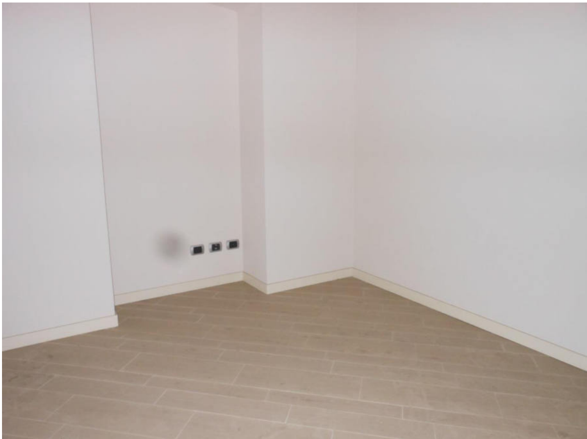
Foto 14 Camera alloggio sub.20
