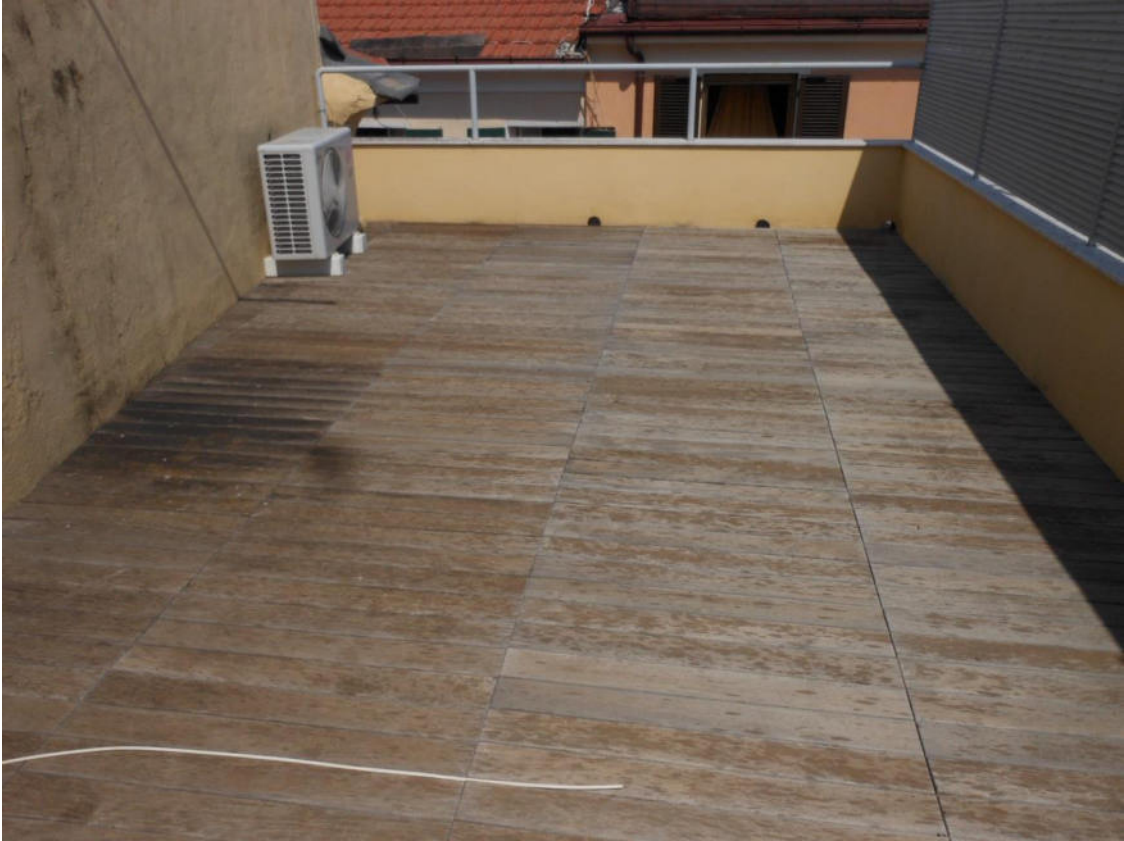
Foto 17 Lastrico solare sub.21
