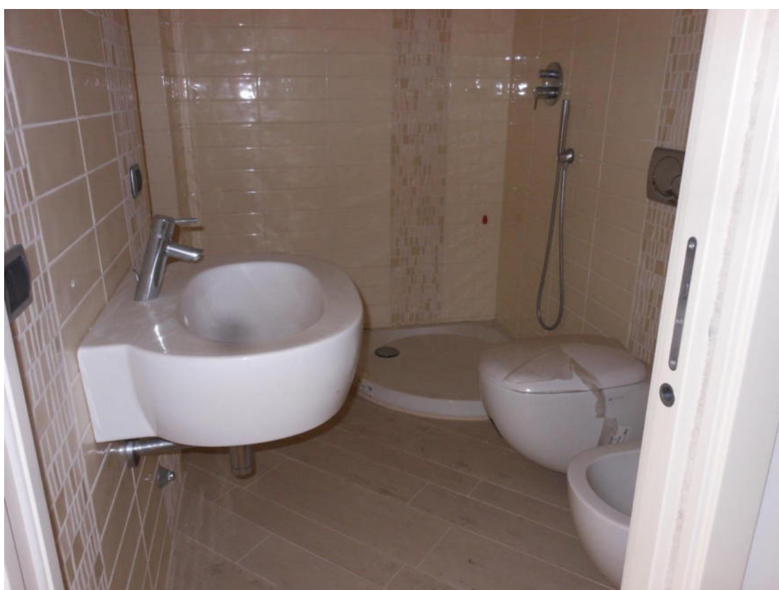
Foto 12 Bagno alloggio sub.20
