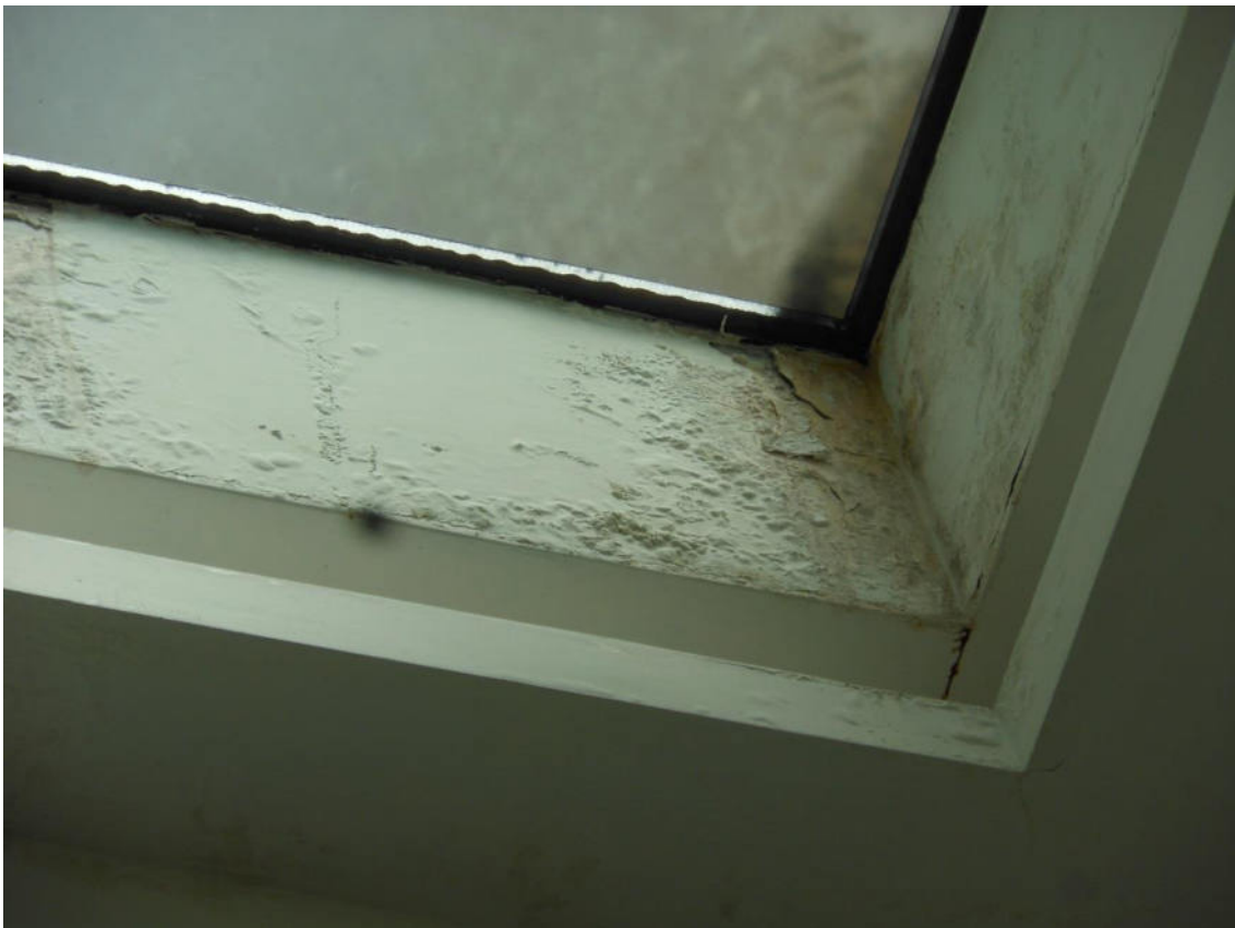
Foto 16 Particolare infiltrazioni su unità immobiliare sottostante
