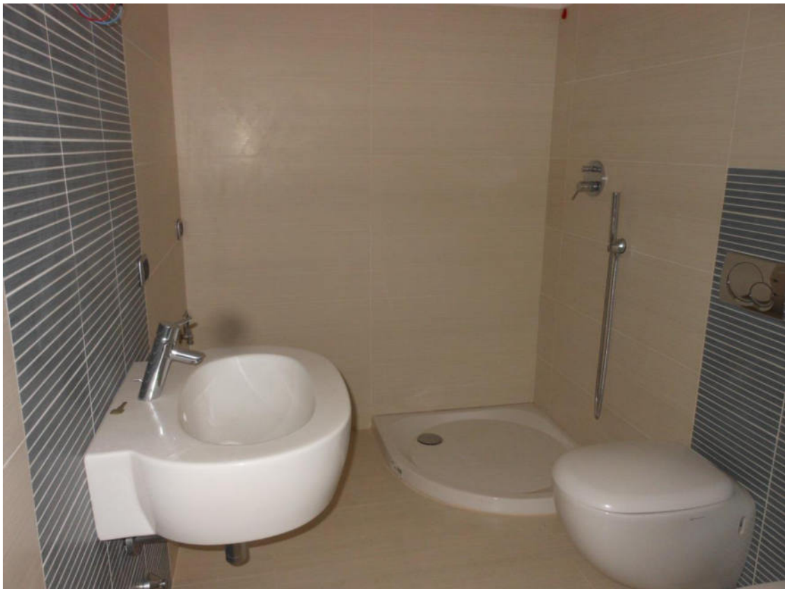
Foto 6 Bagno alloggio sub.16
