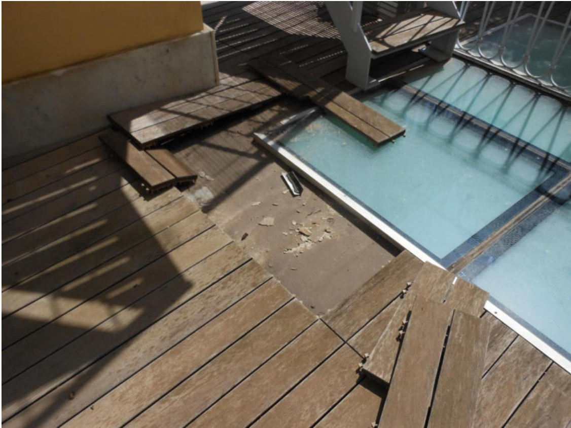
Foto 15 Terrazzo esclusivo sub.20 oggetto di infiltrazioni
